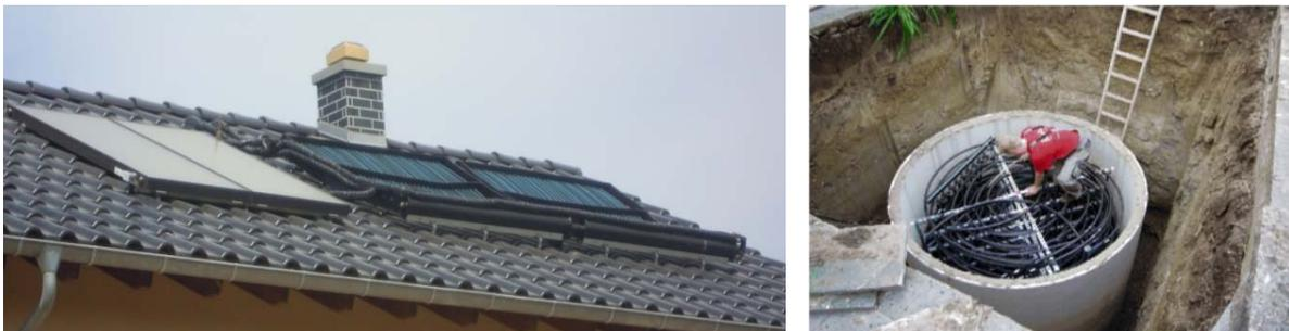
**Abb. 1: a) Solarthermische Flachkollektoren (links), Absorber (rechts), [Quelle: ITW], b) Eisspeicher [Quelle: A. Bühring]**
