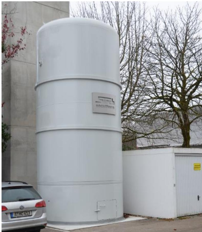
Abbildung 8-9: Warmwasserspeicher mit Vakuumwärmedämmung der Firma Sirch im botanischen Garten in Augsburg (Höhe gesamt 7 m, Durchmesser außen 3 m, Speichervolumen ca. 26 m<sup>3</sup>).
