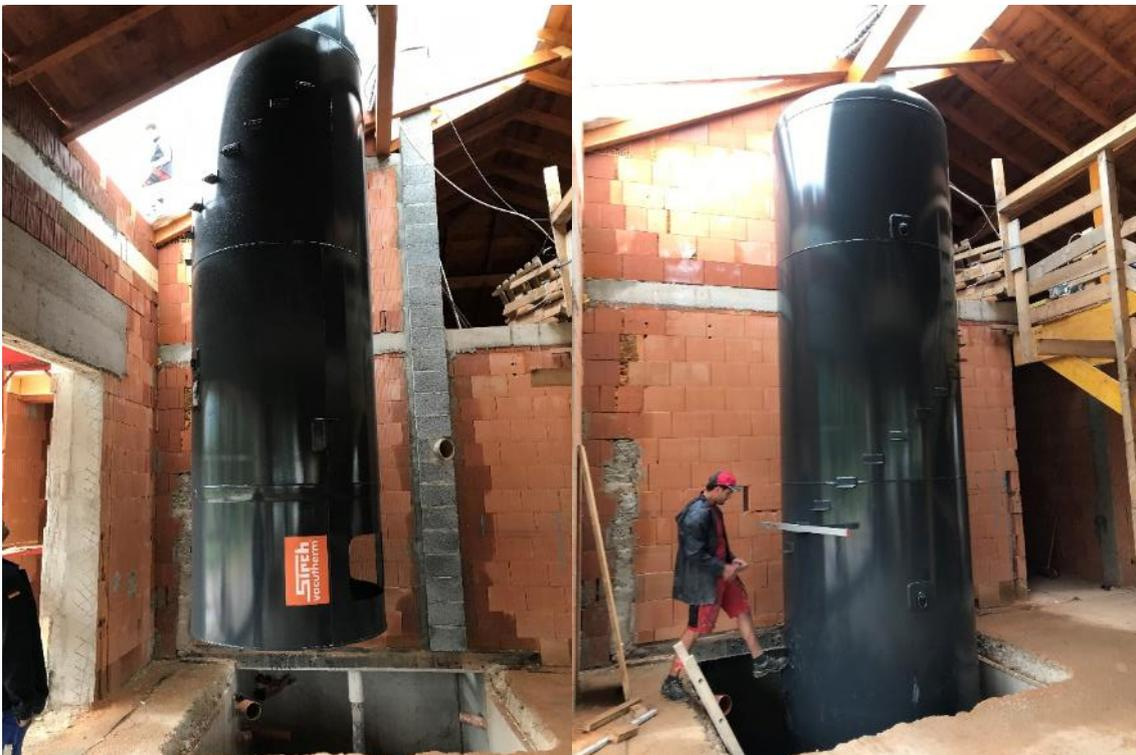
Abbildung 7-2: Zweiter gefertigter Pilotspeicher während der Einbringung (links) und am Aufstellungs-orts positioniert (rechts) in einem EFH in Kirchdorf an der Krems (Österreich).
