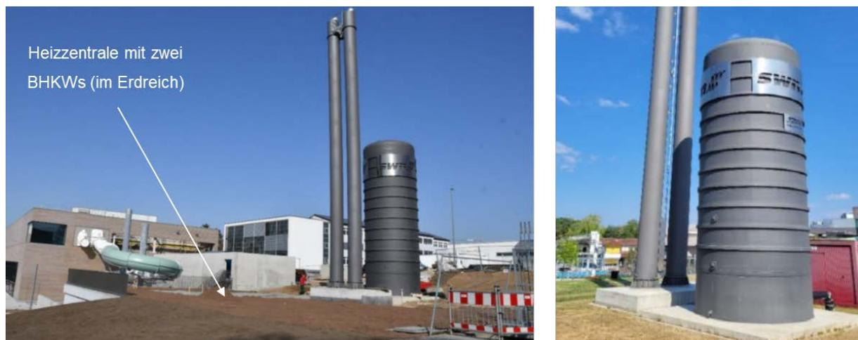
Abbildung 8-1: Pilotspeicher mit Vakuumschichten und einem Speichervolumen von 60,6 m<sup>3</sup> aufgestellt auf der Liegewiese im neuen Schlossbad in Neumarkt i. d. Oberpfalz. Foto: Stadtwerke Neumarkt.
