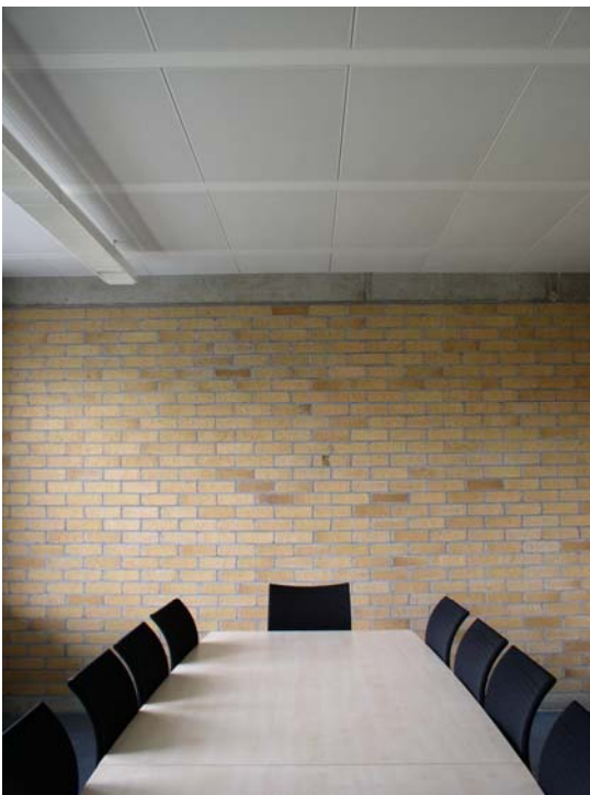
Abb. 5-2: Kühldeckeninstallation am ITW
