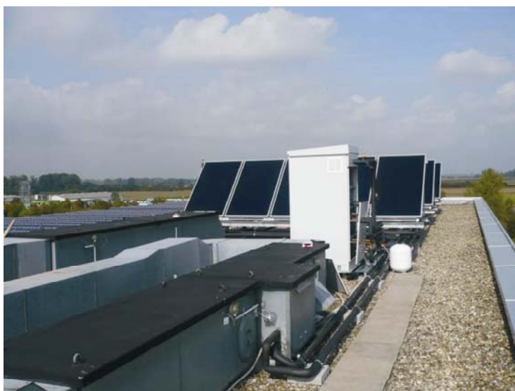
Abb. 8.2: Prototypenanlagen in Groß Rohrheim
