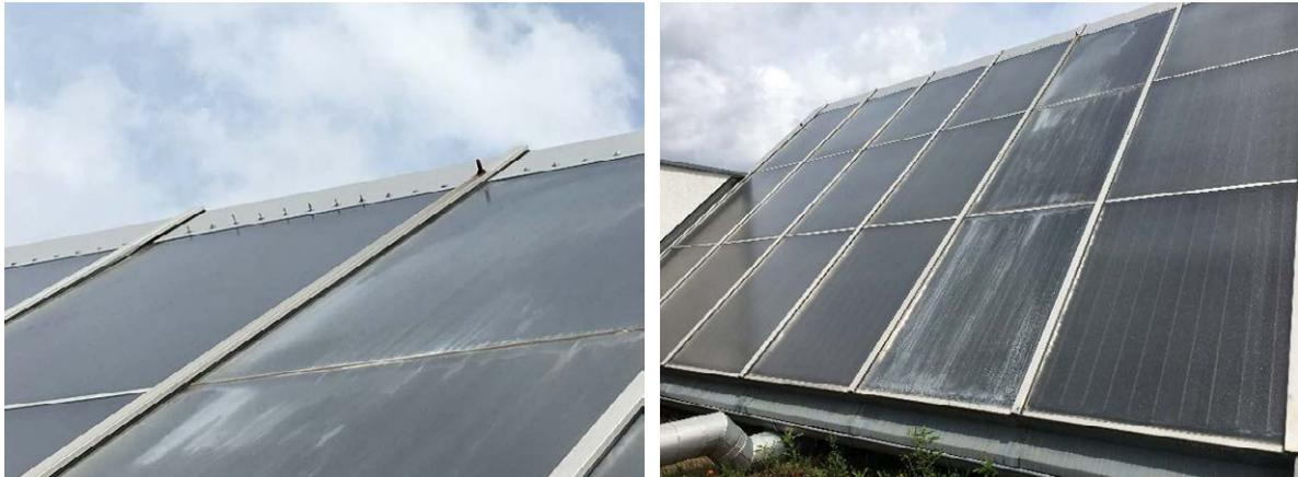
Abbildung 54: Gelockerte Schrauben und Kondensatausfall an den C-Feldern im Juni 2017 (HK)
