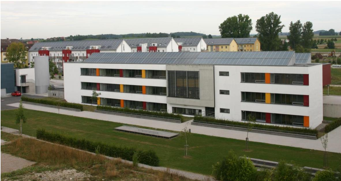
Abbildung 33: Schule im Wohngebiet Hirtenwiesen II mit auf dem Dach installierten Sonnenkollektoren. Im Hintergrund Mehrfamilienhäuser mit dachintegrierten Sonnenkollektoren. Links neben der Schule ist einer der Pufferspeicher der SuN-Anlage zu sehen.
