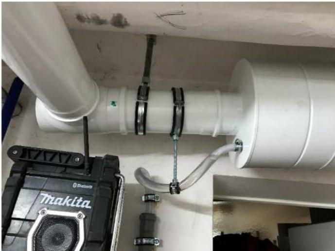
Abbildung 6: Selbstgebauter Siphon des Abgas- und Frischluftrohrs
