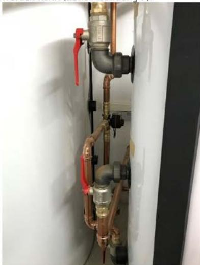
Abbildung 7: Nach Fertigstellung schwer erreichbare Bauteile
