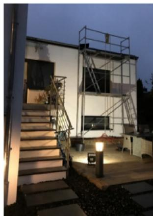
Abbildung 2: Aufgebautes Gerüst
