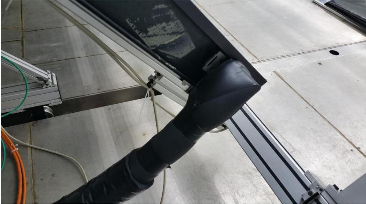
**Abbildung 71:** Kollektor mit wärmegeädämmtem Anschluss des Kollektoreintritts
