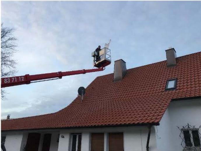
Abbildung 5: Montage des Abgas- und Frischluftrohrs mit einer LKW-Arbeitsbühne
