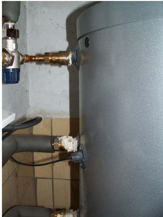
**Abbildung 62:** Beispiel ungedämmte Speicheranschlüsse
