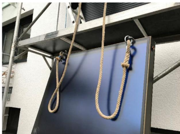
Abbildung 3: Seile werden am Kollektor befestigt
