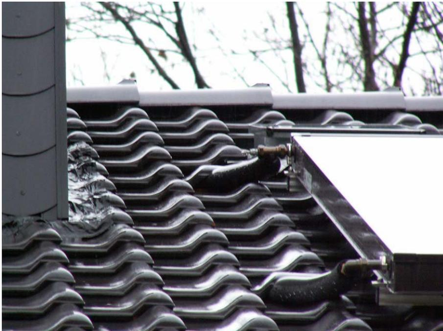
**Abbildung 60:** Beispiel Kollektoranschlüsse ohne Wärmedämmung
