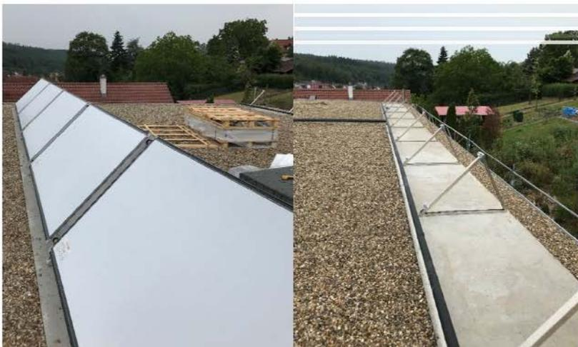
Abbildung 4: Montierte Solarkollektoren und Aufständer
