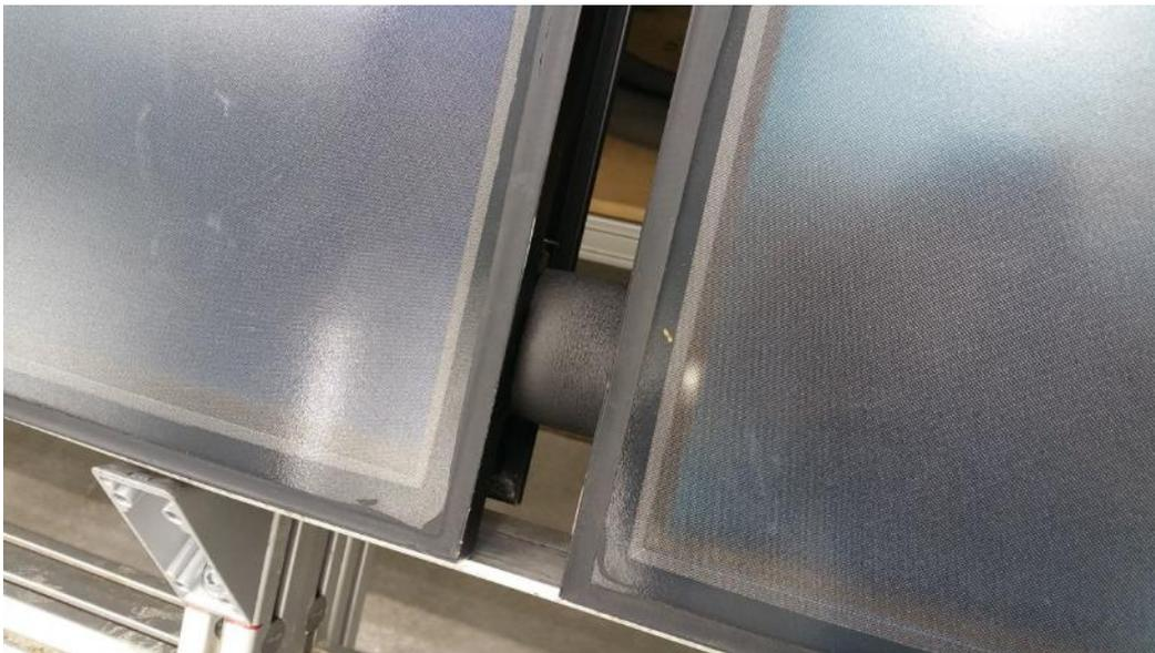
**Abbildung 72:** Wärmegeädämmte hydraulische Kollektorverbinder
