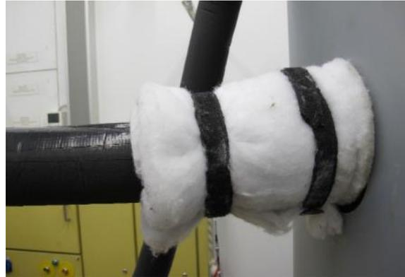
**Abbildung 36:** Lamellenkonvektionsbremse mit Polypropylen-Gewindestange und 6 bzw. 4 Scheiben (oben links und oben rechts); eingeschraubte LKB im Speicheranschluss (u. l.) und Wärmedämmung des Anschlussrohrs (u. r.)
