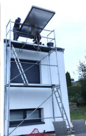
Abbildung 4: Kollektor wird mit Seilen auf das Dach gezogen
