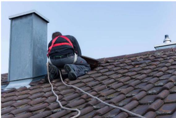
Abbildung 2: Montage auf dem Dach mit Klettergurt
