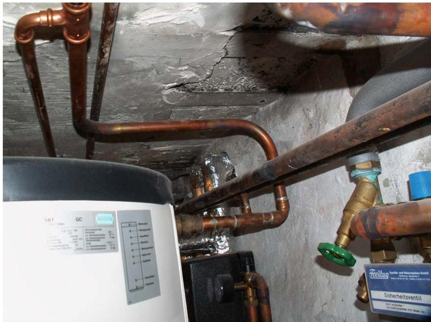
**Abbildung 64:** Beispiel ungedämmte Rohrleitungen
