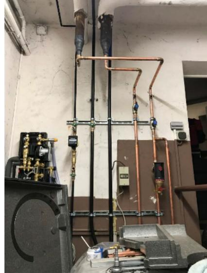
Abbildung 3: Verrohrung mit Kuper- und Kunststoffrohren
