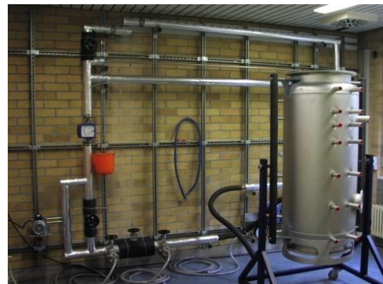
Abbildung 39: Verrohrung des Solarkreislaufs im Labor
