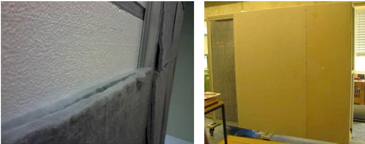
**Abb. 5.8:** Aufbau der Trockenbauwand: Metallständer mit Aerogelfilz-Wärmedämmung (links), auf die Metallständer aufgeschraubte Gipsplatten mit integriertem PCM (rechts)
