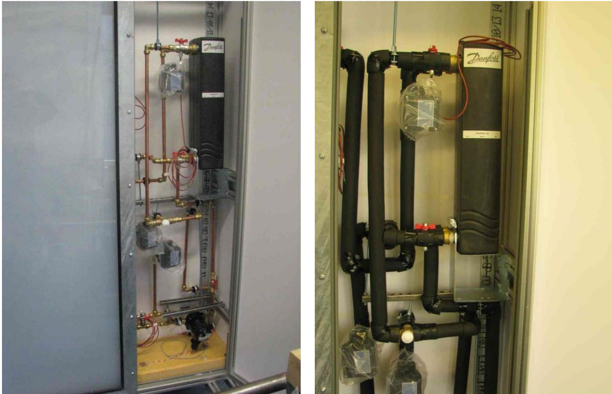
**Abb. 5.12:** Eingebaute Hydraulik einschließlich Messtechnik im ungedämmten Zustand (links) und im gedämmten Zustand (rechts)
