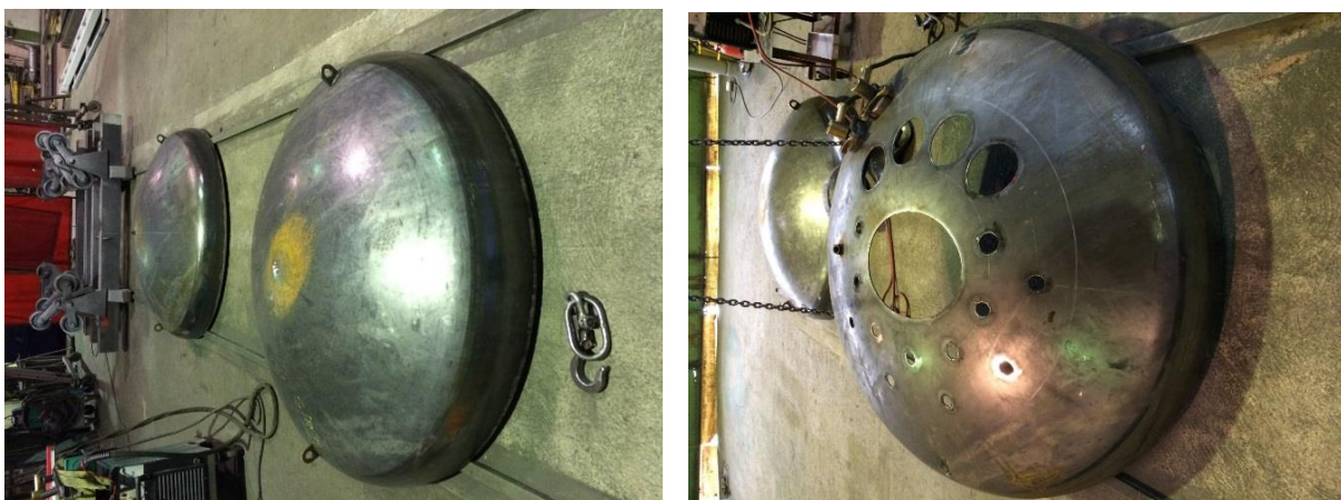
Abbildung 40. Fertigungsverfahren, Ausrichten der Böden (links) und ausbrennen der Durchbrüche (rechts)
