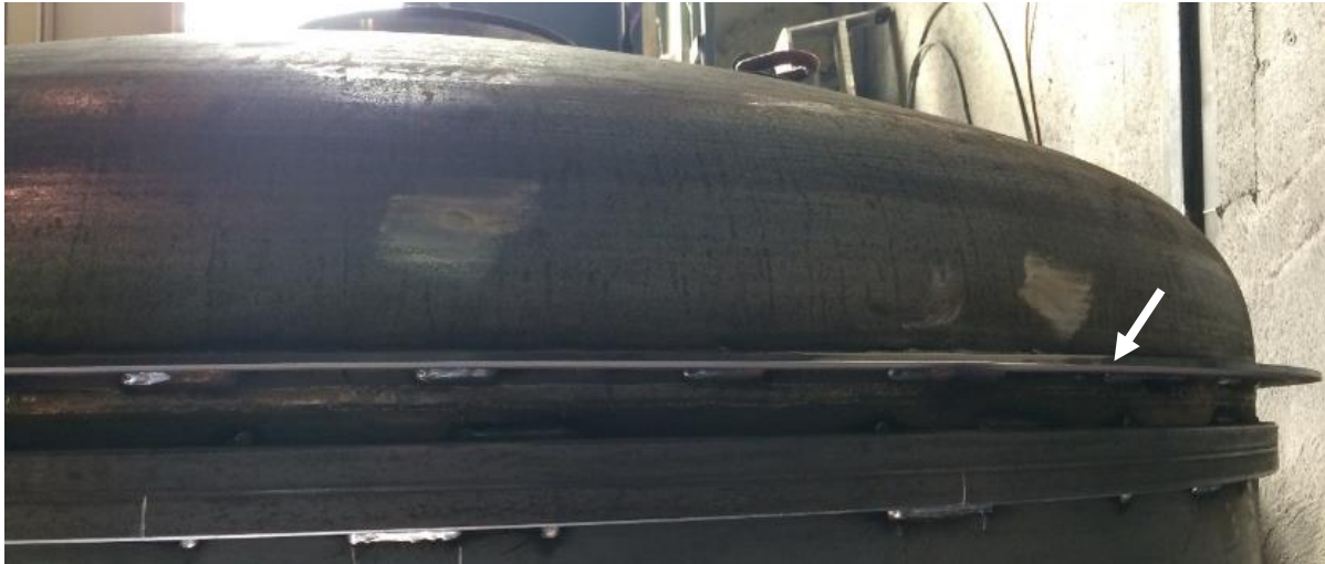
Abbildung 47. Tropfkante (markiert mit weißem Pfeil) mit darunter positioniertem U-Ring
