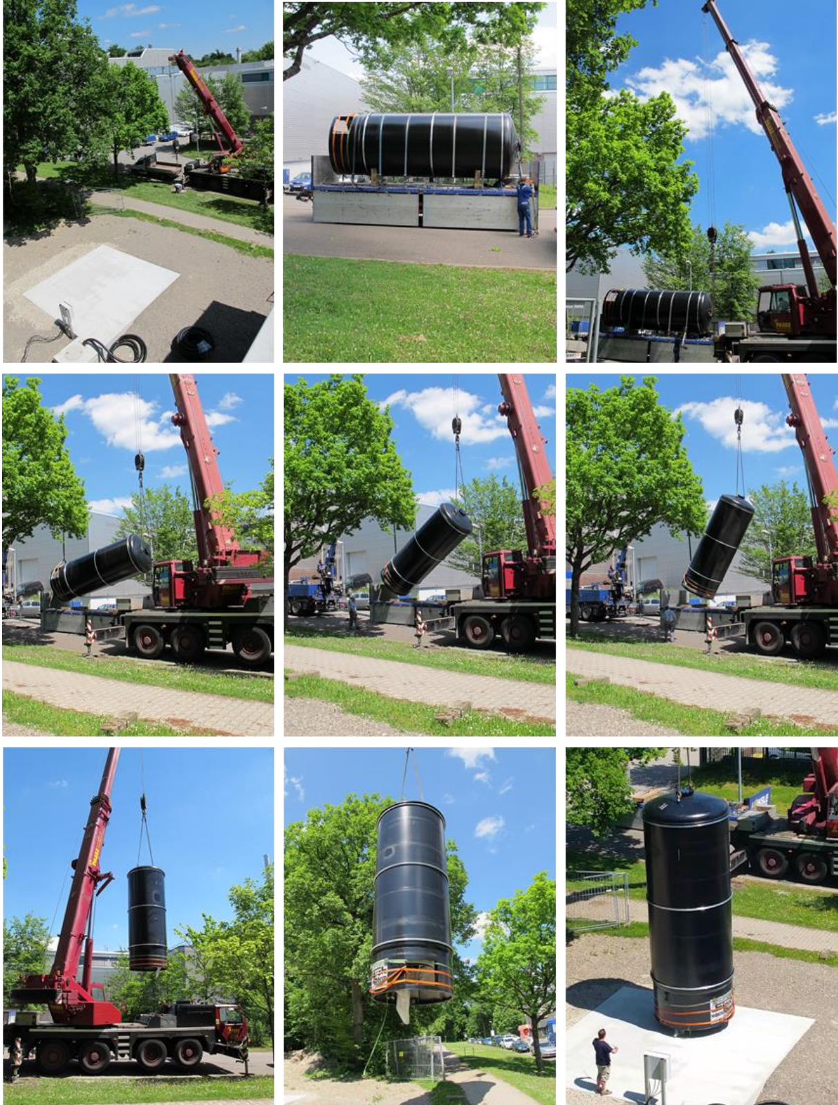
Abbildung 80. Bilderfolge zur Anlieferung und zur Aufstellung des Funktionsmusters am Prüfstand des ITW/TZS am 18.05.2015
