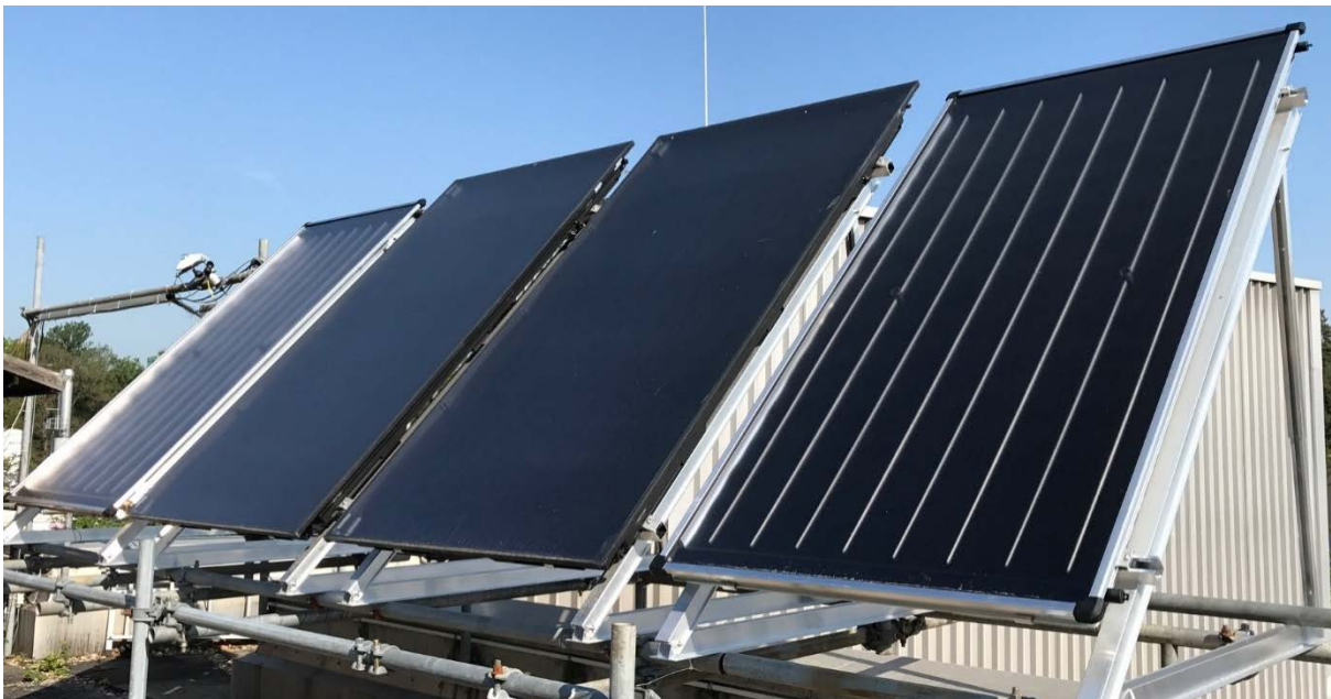
Abbildung 6-13: Exposition der Kollektoren vom Typ K1 (Kollektoren 1 und 4 von links) und K2 (Kollektoren 2 und 3 von links)
