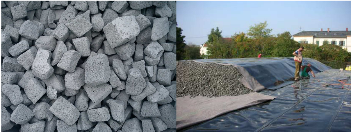
Abbildung 4-2: links: SGS der Körnung 30 mm – 50 mm als loses Schüttgut; rechts: In einzelne Folientaschen eingeschweißte SGS-Schüttungen zur Dämmung des Deckels des Kies-Wasser-Wärmespeichers in Eggenstein-Leopoldshafen [11]
