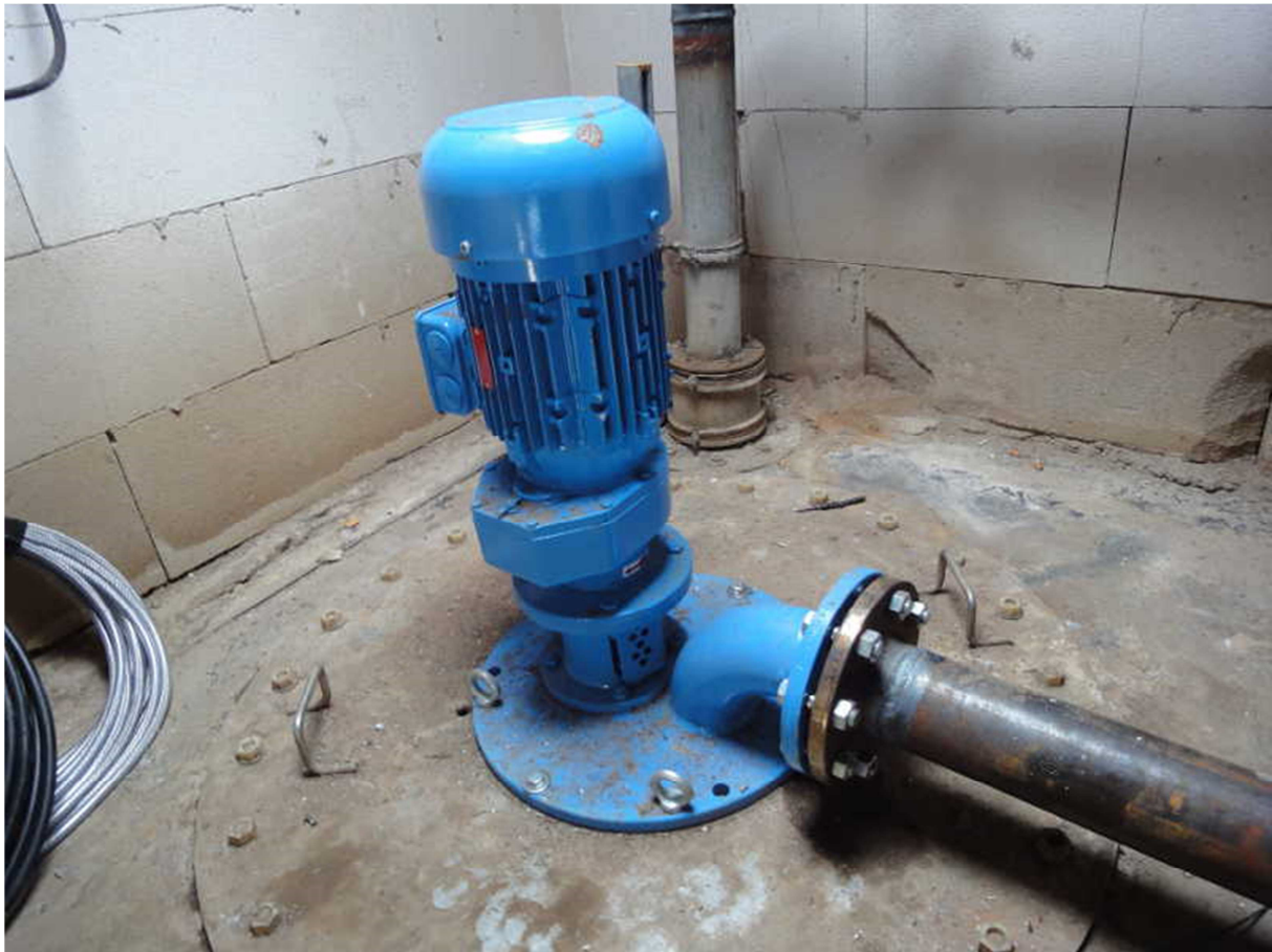
Abbildung 2-3: Selbstansaugende Entladepumpe des KWWS auf Brunnendeckel installiert
