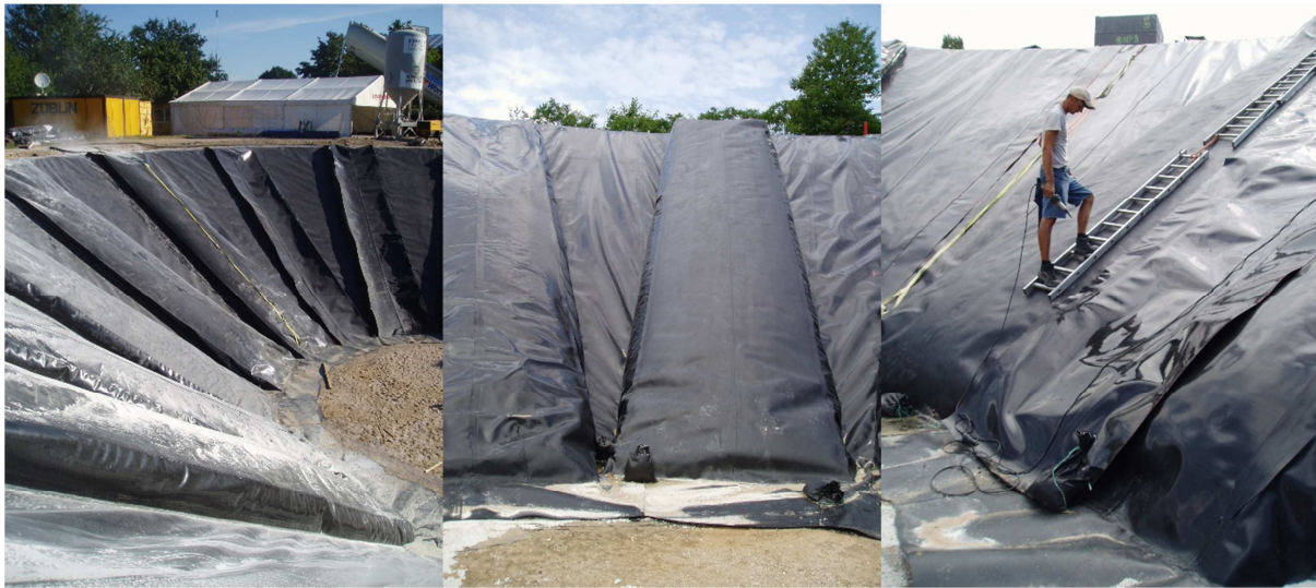
Abbildung 5-4: Links: Befüllung der primären Dämmpakete mit BGG; Mitte: Rechteckiges primäres Dämmpaket mit trapezförmigem Hohlraum; rechts: Herstellung der sekundären Dämmpakete durch Verschweißen der HDPE-Verbundfolie auf die primären Dämmpakete
