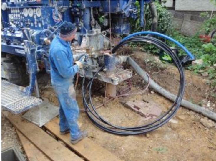
**Abb. 7.47:** Verlegung der Erdwärmesonden mit zusätzlichem Schlauch für die Temperaturfühler
