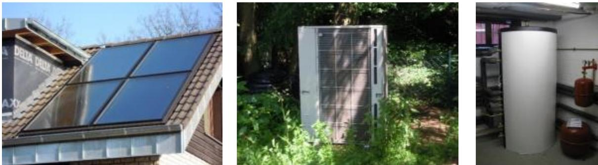
**Abb. 7.3:** Ansicht von links nach rechts: Flachkollektoren, Außeneinheit der Wärmepumpe und Kombispeicher (Fotos: A. Loose)
