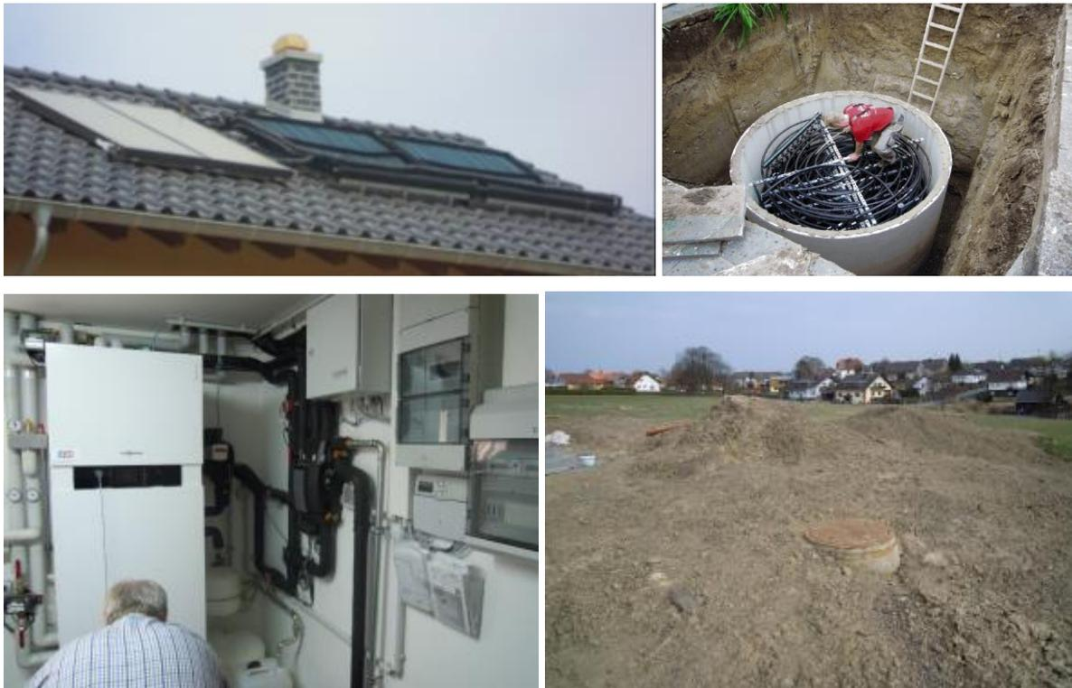
**Abb. 7.34:** Solarthermische Flachkollektoren und Solarabsorber (oben links, Foto: A. Loose), Eisspeicher (oben rechts, A. Bühring), Wärmepumpe mit Schaltschränken (unten links) und Eisspeicher beim Einbau (unten rechts, beide A. Loose)
