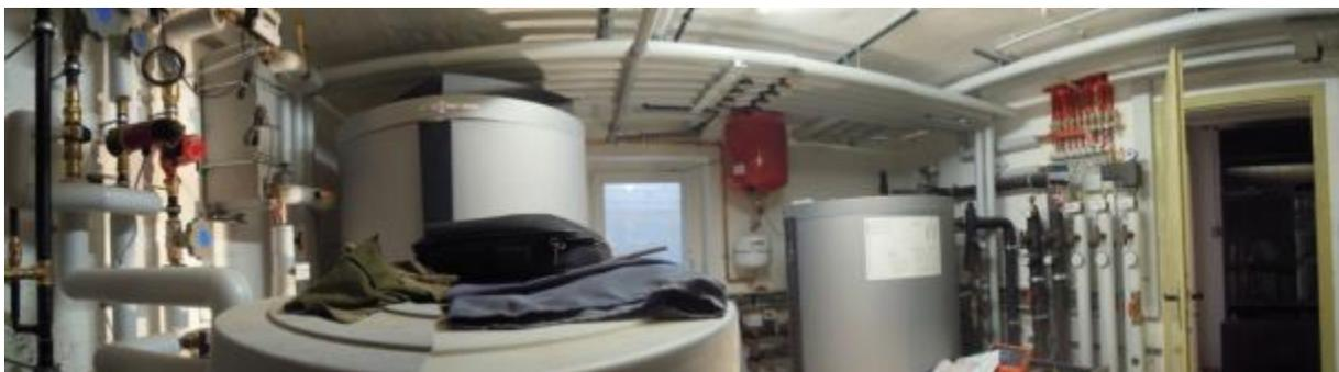
*Abb. 7.44: Ansicht der drei Pufferspeicher im Heizungskeller (Foto: A. Loose)*
