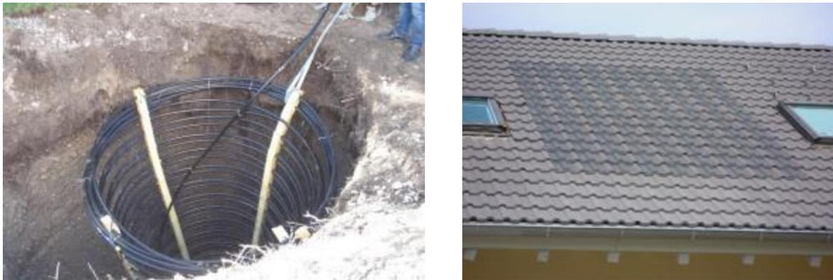
**Abb. 7.71:** Erdwärmekorb (links) und Solardachziegel (rechts) (Fotos: A. Drexler, A. Loose)
