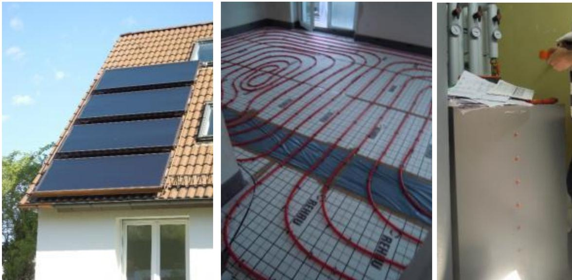
**Abb. 7.45:** Ansicht der Sonnenkollektoren (links), Verlegung der Fußbodenheizung (Mitte) und Ansicht der Wärmepumpe (rechts) (Fotos: A. Loose)
