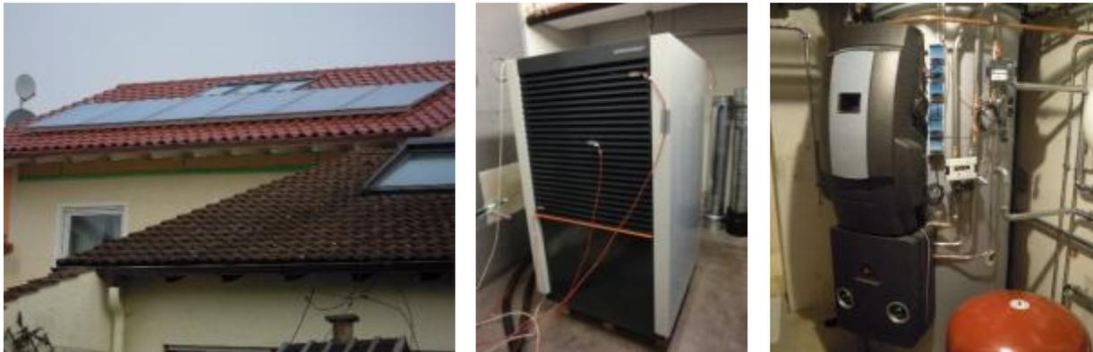
**Abb. 7.58:** Ansicht des Kollektorfeldes (links), Wärmepumpe (Mitte) und Pufferspeicher mit Solar- und Frischwasserstation (rechts) (Fotos: A. Loose, S. Bonk)
