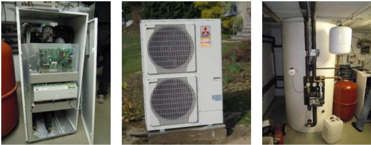
**Abb. 7.24:** Ansicht von links nach rechts: Hydraulikmodul, Außeneinheit der Wärmepumpe und Kombispeicher (Fotos: A. Loose)
