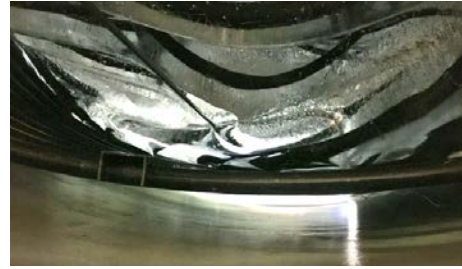
Abb. 20: Blick in den Versuchseisspeicher auf die Eisformation, die sich um die Wärmeübertragerrohre gebildet hat
