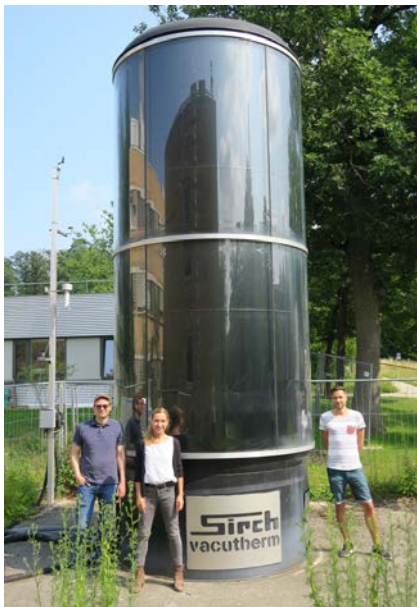
Speicher mit Vakuumpwärmee- dämmung
