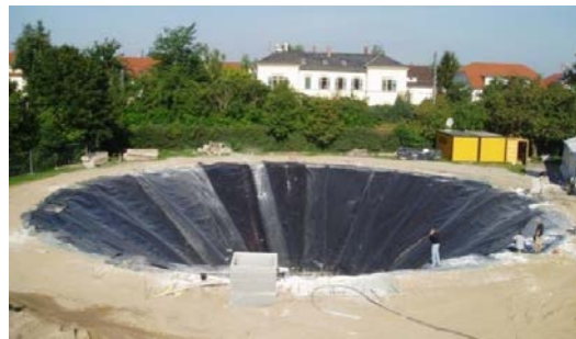
Saisonale Wärmespeicherung in Kombination mit Solarthermie
