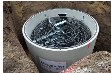
Bild: Eisspeicherbauart Stand der Technik.
