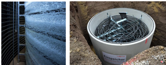
Bild: Links: Eisbildung im Eisspeicher (Quelle: Viessmann). Rechts: Eisspeicherbauart Stand der Technik (Quelle: Ulmer / IMAGO)
