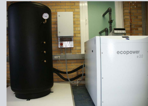
Mini-Blockheizkraftwerk
