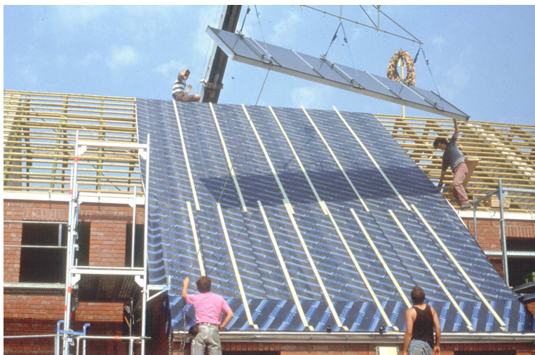
Bild 4: Montage von großen Kollektorflächen in Hamburg
