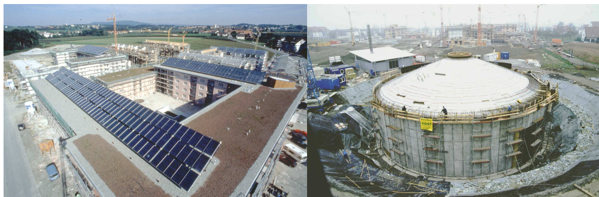
Bild 3: Solar unterstützte Nahwärmeversorgung mit Langzeit-Wärmespeicher in Friedrichshafen (links: Blick auf die Kollektorfelder, rechts: Bau des Heißwasser-Wärmespeichers).
