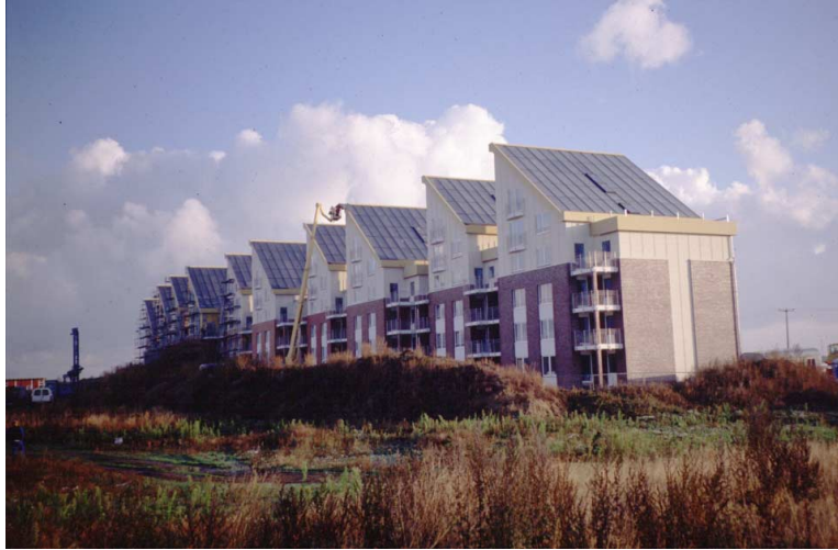
Bild 5: Pilotanlage in Rostock mit Solardach
