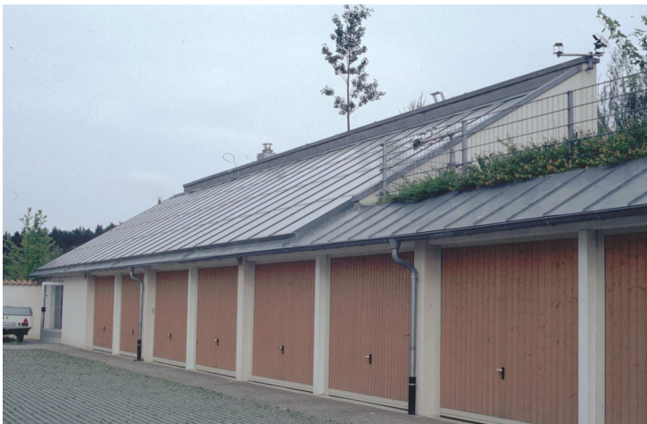
Bild 1: erstes solar unterstütztes Nahwärmesystem in Ravensburg (Betriebsbeginn 1993)
