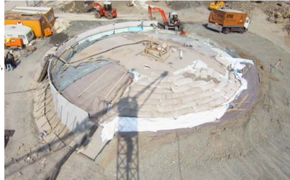
Bild 11: Wandaufbau und Speicher im Bau (Projekt Hannover-Kronsberg)
