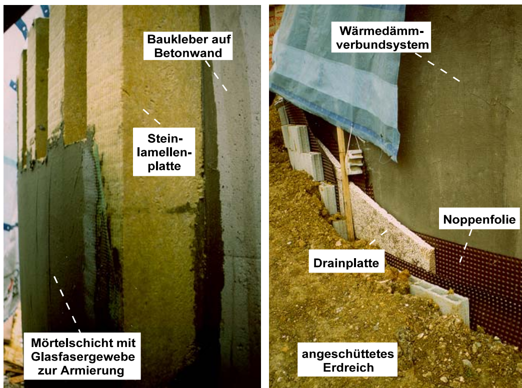
Bild 5: Aufbau der Wärmedämmung an der Wand (Projekt Rottweil)
