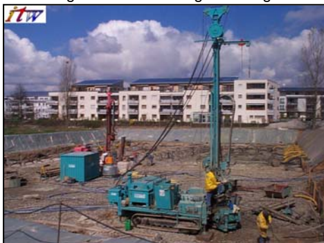
Bild 5: Bau des Erdsonden-Wärmespeichers in Neckarsulm-Amorbach
