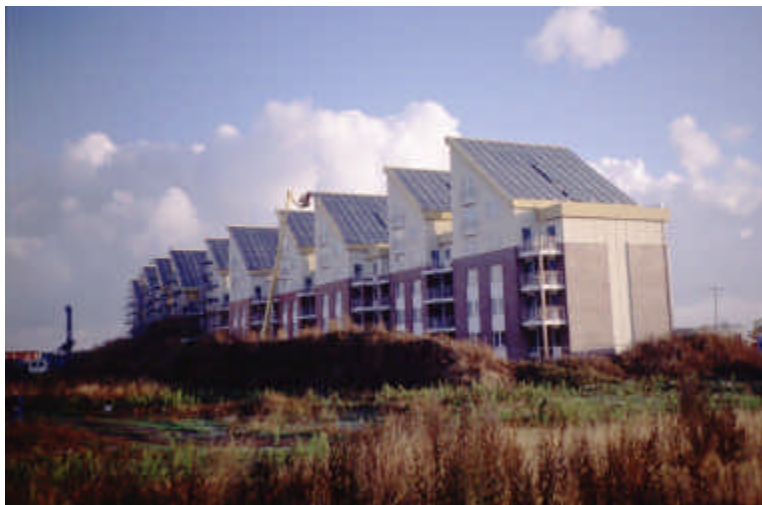
Bild 1: Pilotanlage in Rostock-Brinckmanshöhe
