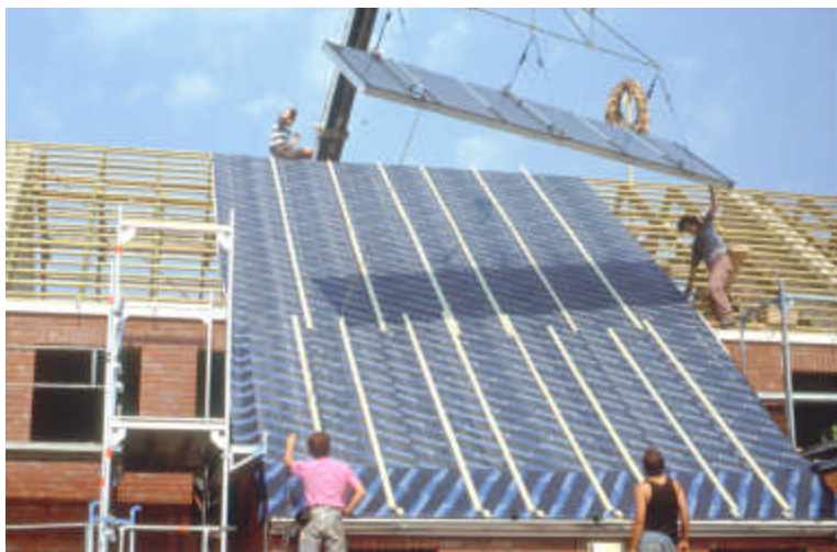
Bild 8: Montage von großen Kollektorflächen in Hamburg
