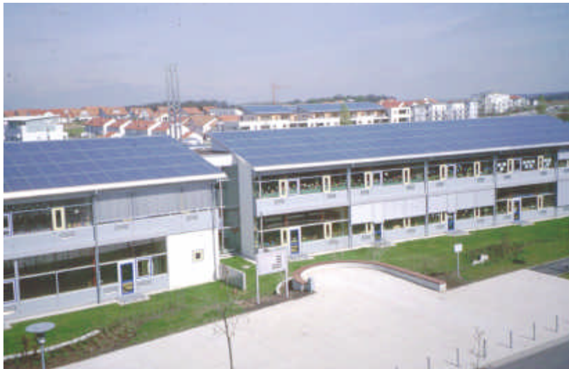
Bild 11: Kollektordach auf der Grundschule in Neckarsulm-Amorbach
