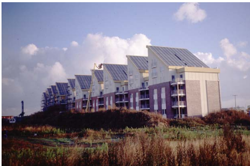
Abbildung 1: Ansicht des Mehrfamiliengebäudes in Rostock mit einem Solarroof mit einer Kollektorfläche von 1000 m 2
