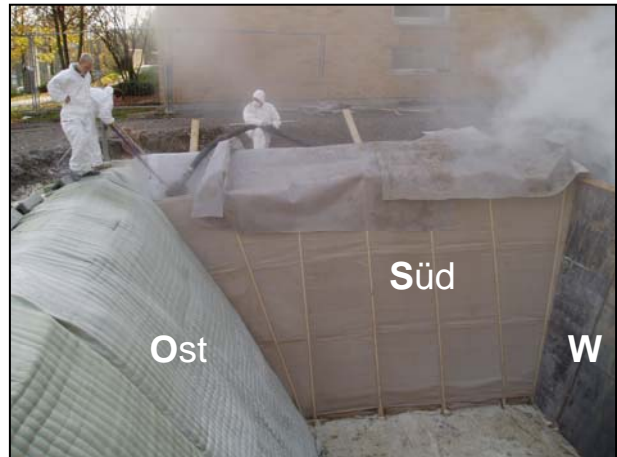
Bild 4: Einblasen der Dämmung, sowie v.l.n.r.: Geocontainer, Membran- und, Holzschalung
