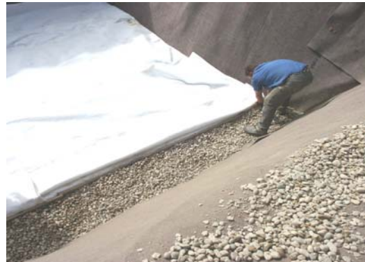
Bild 3: Bau des Forschungsspeichers, links Einbringen der Sandschicht und rechts Einpacken der fertigen Schicht in Fleecestoffe, um das Ausschwemmen des Sandes zu verhindern; zu erkennen ist die vertikale Kiesschicht am rechten Rand des Speichers
