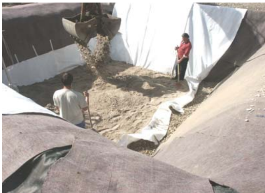
Bild 3: Bau des Forschungsspeichers, links Einbringen der Sandschicht und rechts Einpacken der fertigen Schicht in Fleecestoffe, um das Ausschwemmen des Sandes zu verhindern; zu erkennen ist die vertikale Kiesschicht am rechten Rand des Speichers
