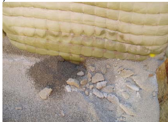
Bild 5: Die Durchfeuchtung der Nordwand (W2), sowie des Bodens (B) nach dem Rückbau
