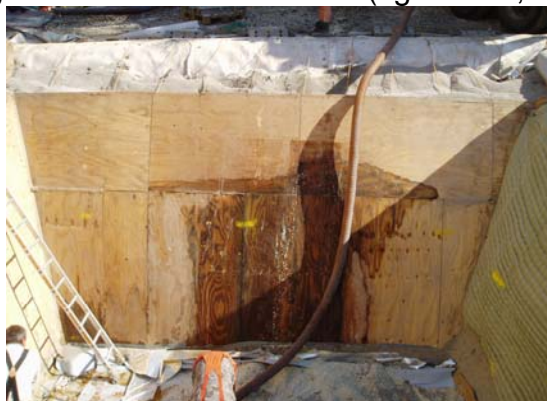
Bild 5: Die Durchfeuchtung der Nordwand (W2), sowie des Bodens (B) nach dem Rückbau
