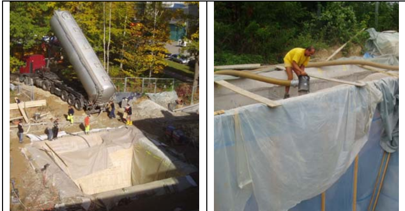
Bild 7: Bau der Außenlabore, Einblasen der Wärmedämmung aus Silo-LKW in eine Membranschalung
