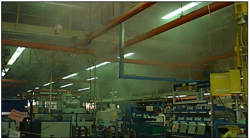
**Bild 2:** Arbeitsbereich unterhalb der Zwischenebene, Zuluftströmung erreicht nur in geringem Umfang den Anforderungsbereich
