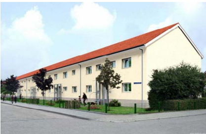
Bild 1: 3-Liter-Haus nach der Sanierung
