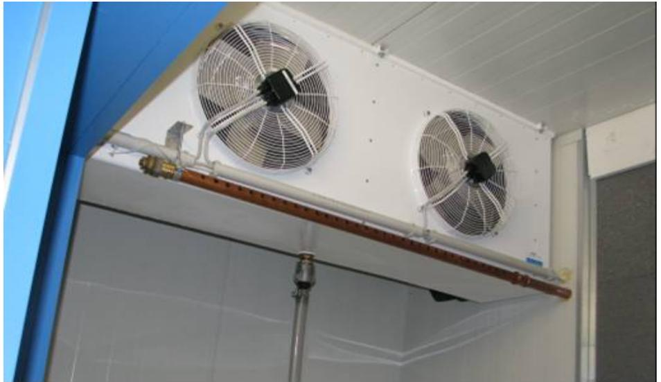
**Bild 2:** Umluftkonditionierer und flexible Zwischenwand
