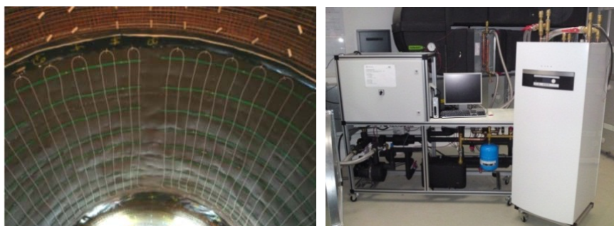
Bild 1: Links: Absorberrohre im Tunnel vor Betonierung, Rechts: Prüfstand im Betriebsraum des Fasanenhoftunnels
