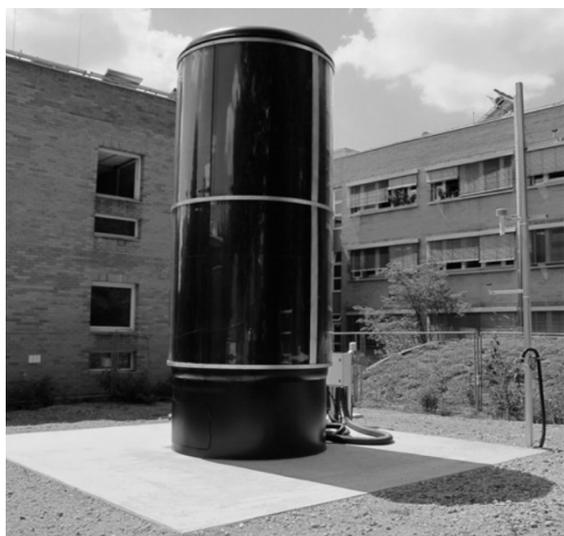
Bild 1: Hocheffizienter, außenaufgestellter WWS mit VWD und TWD ( $12 \text{ m}^3$ )
