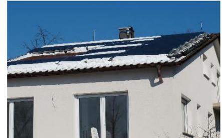
**Bild 1:** Feldtest-Anlage mit 40 m² PVT-Kollektorfeld
