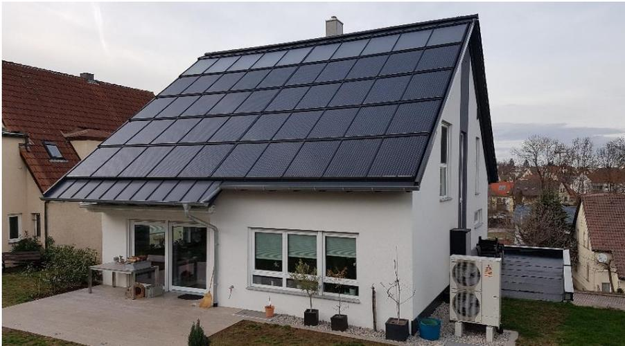
**Bild 1:** SolarAktivHaus<sup>plus</sup> in der Nähe von Heilbronn. Gut zu erkennen sind die 15 m<sup>2</sup> (10,5 kW) solarthermischen Kollektoren direkt unterhalb des Firstes und die 62 m<sup>2</sup> (9,4 kW<sub>p</sub>) Photovoltaik-Module auf dem restlichen Süddach. Rechts neben dem Gebäude steht die Außeneinheit der als Zusatzheizung dienenden Luft-Wasser-Wärmepumpe. Quelle: KHB-Creativ Wohnbau/Marco Jens
