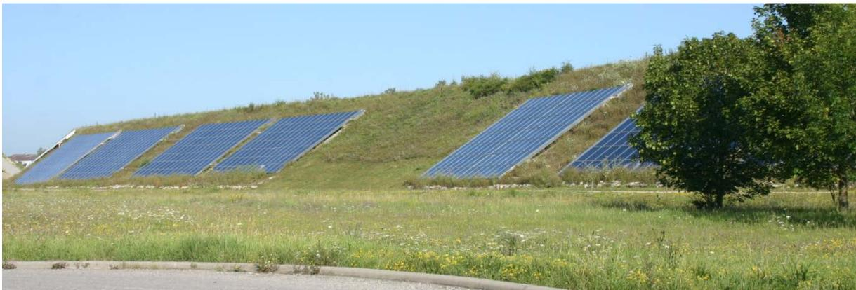
**Abb. 37: Kollektorfelder am Lärmschutzwall Ost**
