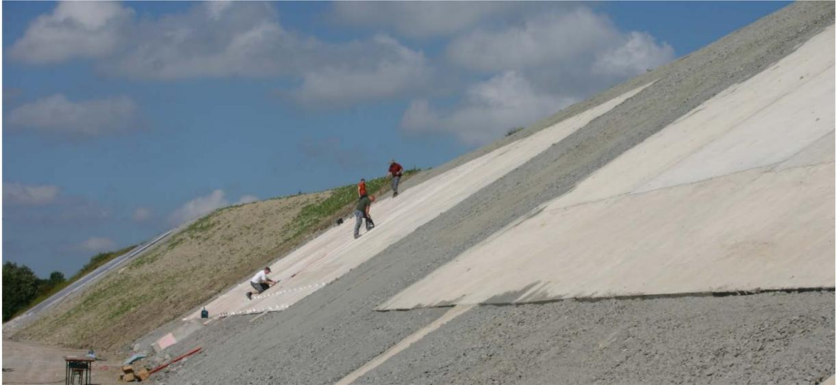
**Abb. 39: Unterkonstruktion für die Kollektoren auf dem Lärmschutzwall West**
