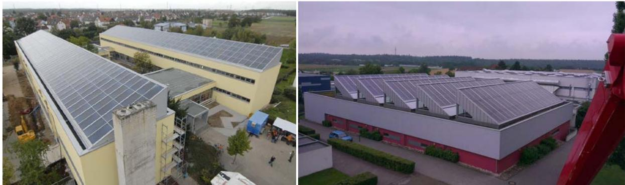
**Abb. 25: Fotos der Kollektorflächen:  $1\,000 \text{ m}^2$  auf dem Schulgebäude (links, Quelle: PKi) und  $600 \text{ m}^2$  auf der neuen Sporthalle (rechts)**
