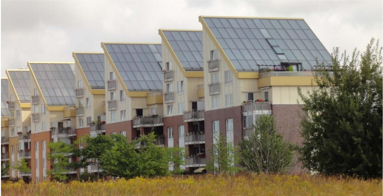
**Abb. 6: Blick auf das Helios-Gebäude in Rostock mit dachintegrierten Solarkollektoren**
