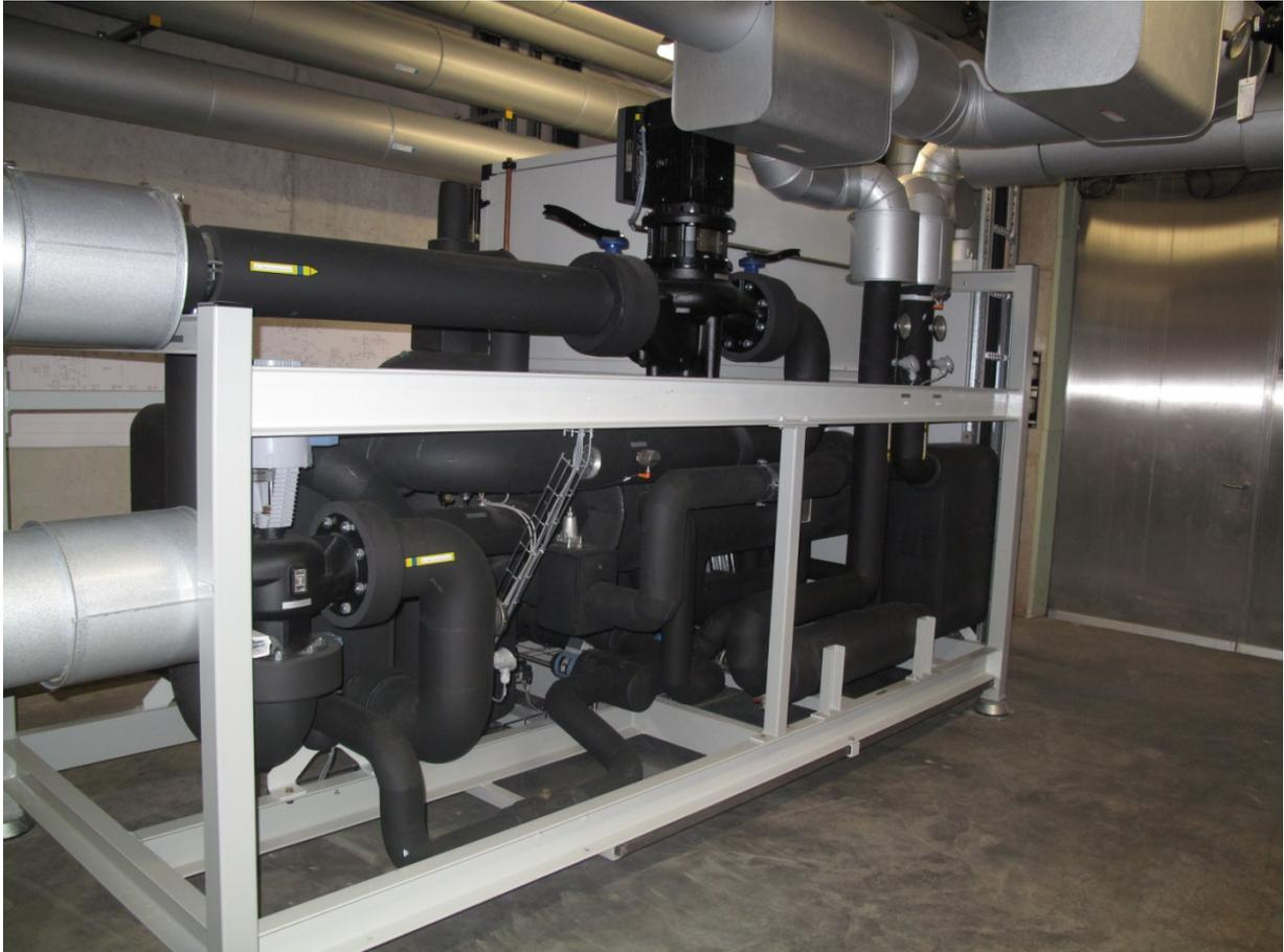
**Abb. 42: Wärmepumpe der solaren Nahwärmeversorgung Crailsheim**
