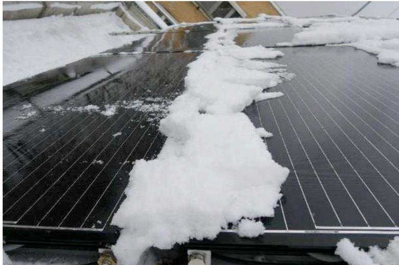
Abbildung 42: Tendenz zum Verfüllen der horizontalen Spalte während des Schneeabrutschens am PVT-Kollektorfeld ohne Spaltabdeckungen.
