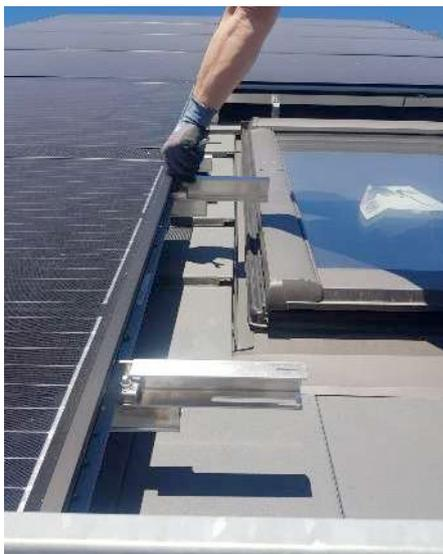
Abbildung 61: Einbausituation mit Dachfenster: vorgesehene seitliche Abschlussbleche würden kollidieren
