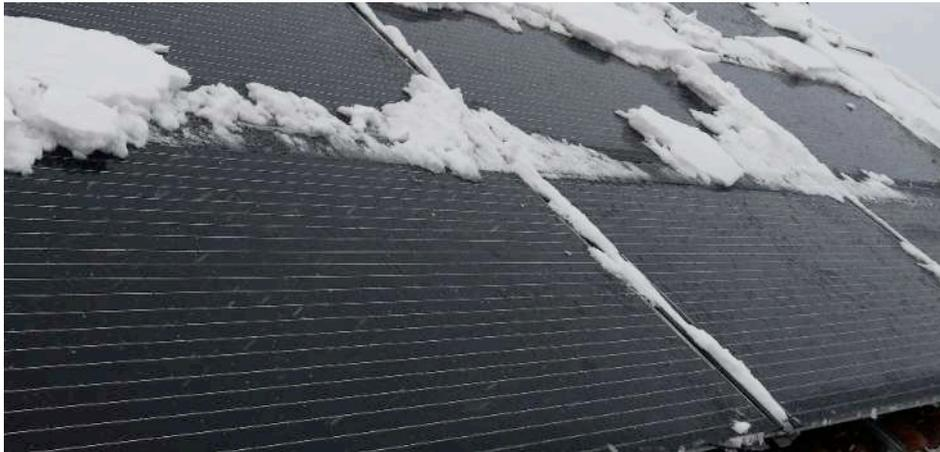
Abbildung 44: Beobachtete Tendenz zum Festfrieren/Anhängen von Schnee an den unbeheizten Lochblechen zwischen den Modulen während des Schneeabrutschens (am PVT-Kollektorfeld mit Lochblech-Spaltabdeckungen).
