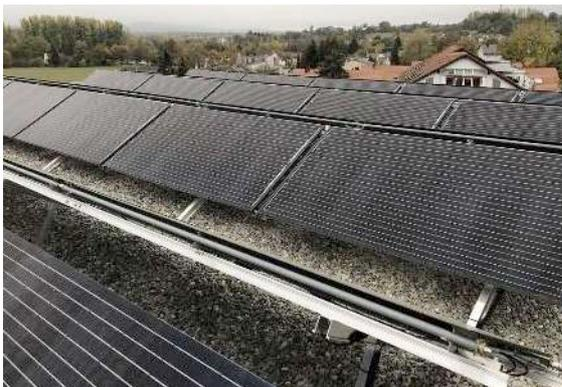
Abbildung 62: Auf dem Flachdach aufgeständert montierte SOLINK-Kollektoren (Ost-West)
