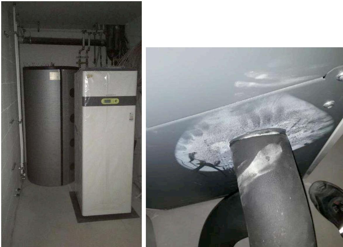
Abbildung 66: Links: Beispiel für beengte Platzverhältnisse in Technikraum. Rechts: Nicht ausreichende Wärmedämmung der Wärmepumpe für die auftretenden tiefen Temperaturen – hier allerdings eine Woche Non-stop-Betrieb und hohe Feuchte beim Estrich-Aufheizen.
