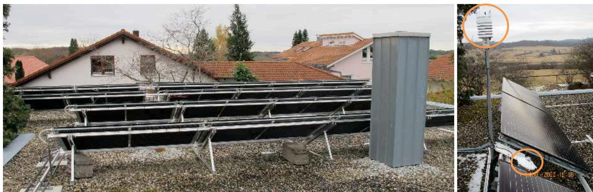
Abbildung 75: Rückseitiges Kollektorfeld (links) und Messtechnik zur wissenschaftlichen Überwachung der Feldtestanlage Sonnenbühl (rechts): Wetterstation zur Erfassung von Windgeschwindigkeit, Windrichtung und Niederschlag sowie Pyranometer zur Erfassung der Einstrahlung in Kollektorebene.
