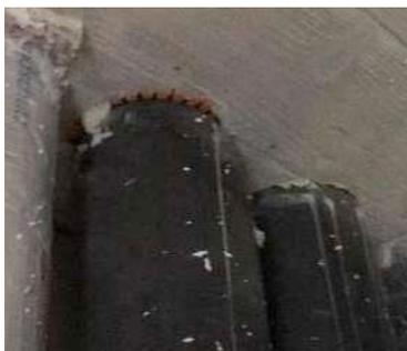
*Abbildung 65: Rohrleitungsdurchgang durch Decke mit brandschutztechnisch zugelassener Dämmungsmanschetten für Durchgänge.*
