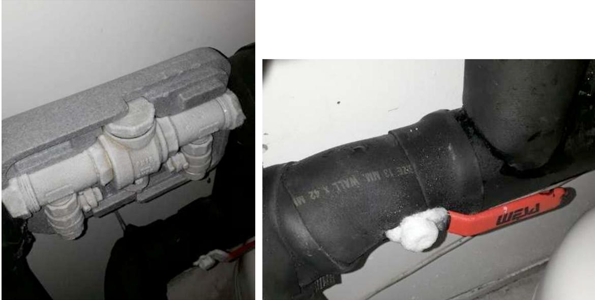
Abbildung 67: Links: Vereiste Spülgruppe (Zubehör des Wärmepumpenlieferanten) da nicht kondensatsicher wärmedämmt. Rechts: Vereisung an ungedämmtem Hebel eines Absperrhahns, ebenfalls beim Estrich-Aufheizen.
