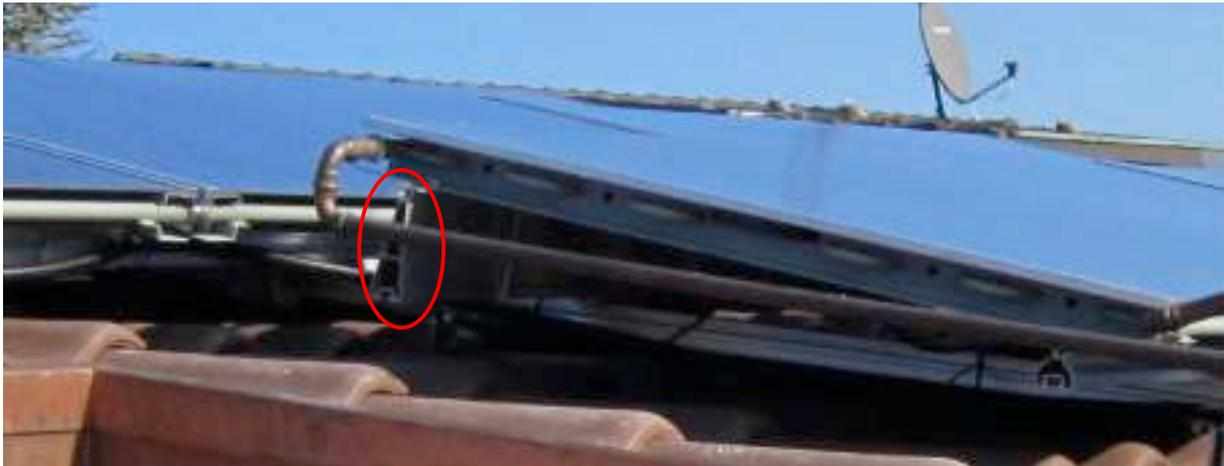
Abbildung 85: Aufgeständerte Kollektormontage bei der Feldtestanlage 1: das geschlossene Aufständersprofil (Oberkante Kollektor, rot markiert) behindert die Hinterlüftung des Kollektors.
