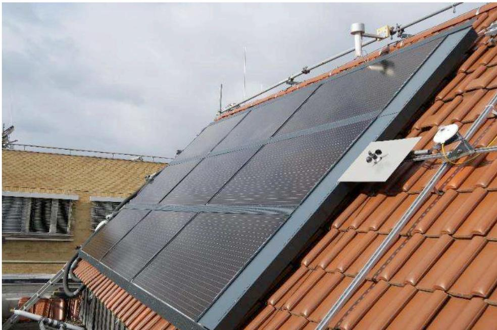
*Abbildung 37: Kollektorfeld mit Lochblechen zwischen den PVT-Modulen und entlang der Ober- und Unterkante sowie einer geschlossenen Seiteneinfassung (Konfiguration D).*
