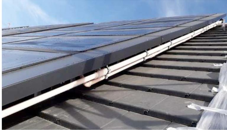
*Abbildung 63: Kollektorfeld mit seitlichen Abdeckblechen, unter denen die Soleleitungen verlaufen*
