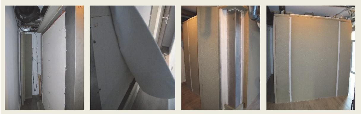
Abbildung 45: Speicherseitenwand aus Silicatplatten, Vlies, PU-Hartschaumdämmung
