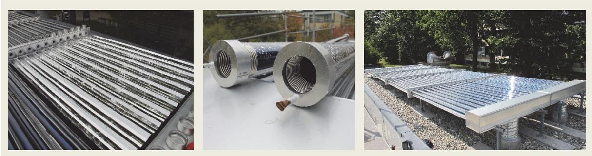
Abbildung 38: Vakuurröhren-Luftkollektor mit Reflektor auf dem Dach des SolSpaces Gebäudes
