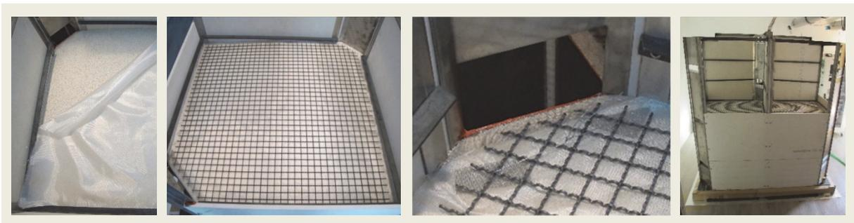
Abbildung 41: Abdeckung eines Segments mit Glasfasermatte und Wellengitter
