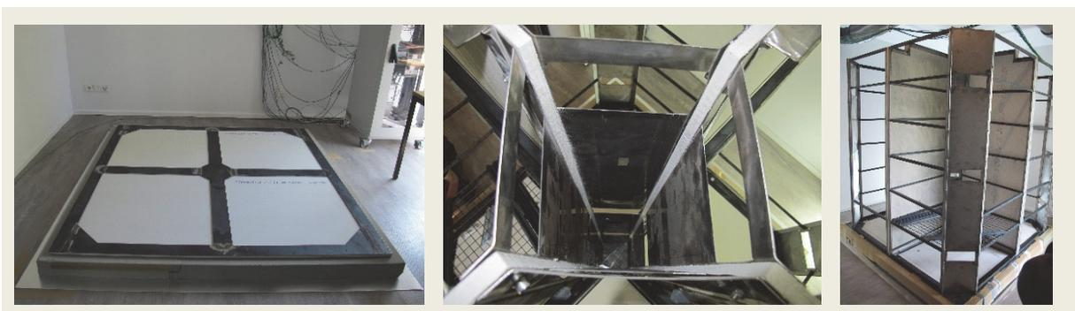
Abbildung 39: Bodenaufbau, zentraler Lufteintrittskanal, Traggerüst
