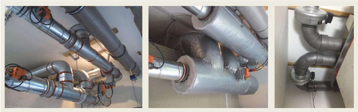
Abbildung 47: Verrohrung mit Wickelfalzrohr und Luftklappen (links), mit Vliesdämmung (Mitte), Lüfter und Isoduct-Rohre (rechts)
