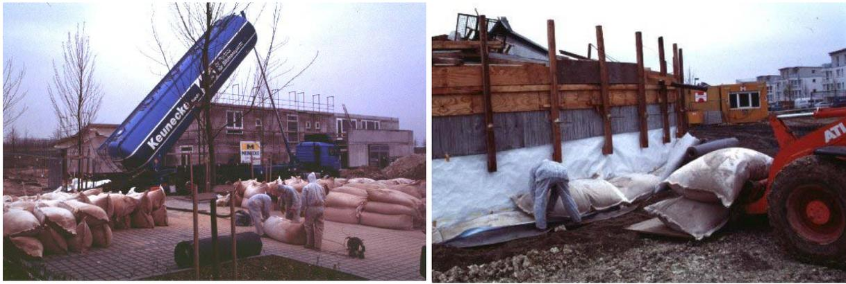
**Bild 4.9:** Abfüllen und Einbringen der Wärmedämmung
