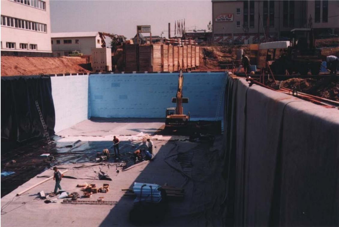
**Bild 4.15:** Bau des Chemnitzer Kies-Wasser-Wärmespeichers zur Zeit der Montage von Folie und Vlies vor der Befüllung mit Kies
