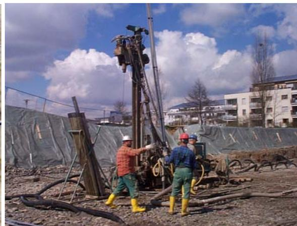
**Bild 4.23: Einbringung der Sonden beim 2. Ausbau**
