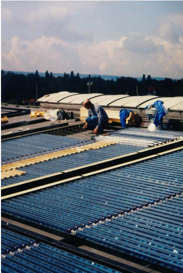
**Bild 2.50: Montage der Vakuum-Röhrenkollektoren**
