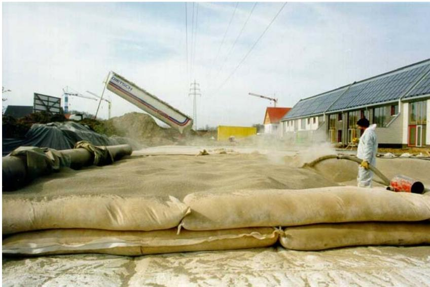
**Bild 4.17:** Einblasen der Decken-Wärmedämmung aus dem Silo-LKW (Quelle: PKI)
