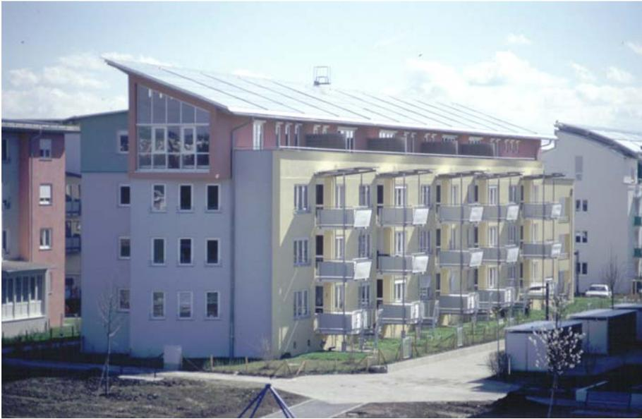
**Bild 2.2: Dachintegriertes Kollektorfeld auf einem Wohngebäude des Siedlungswerkes (1. Bauabschnitt) in Friedrichshafen**
