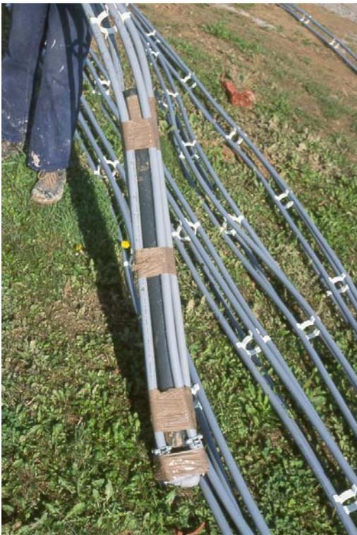
**Bild 4.34: Erdwärmesonde aus Polybuten mit Abstandshalter**
