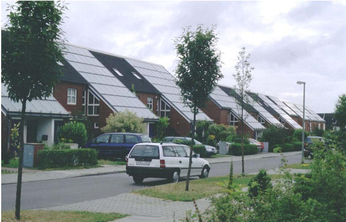
**Bild 2.12: Dachintegriertes Kollektorfeld auf Wohngebäuden in Hamburg im Jahr 2001**
