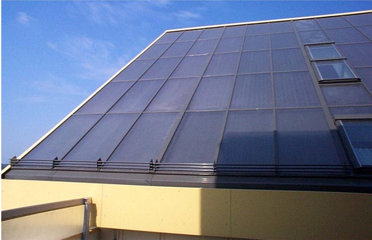
**Bild 2.56: Solardach mit integrierten Dachfenstern und Blindelementen (unten sowie ober- und unterhalb der Dachfenster)**
