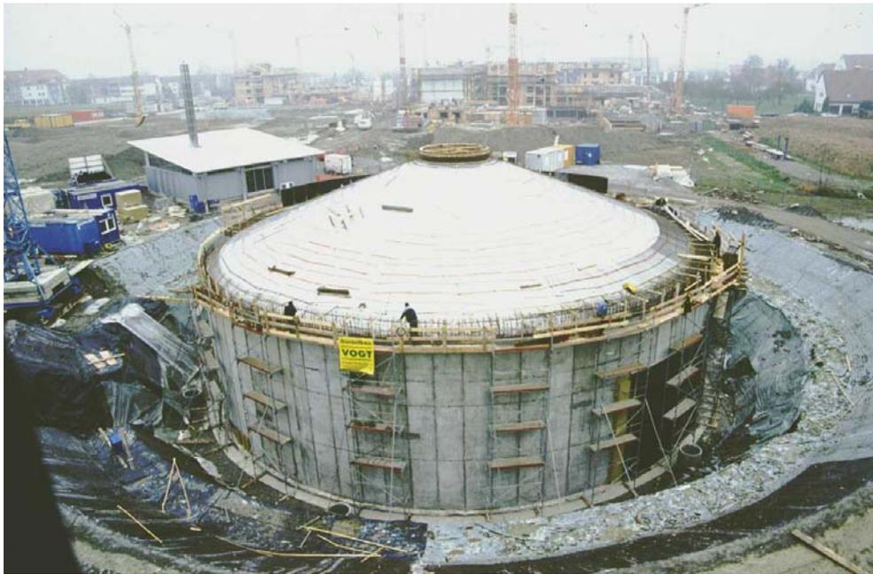
**Bild 4.2:** Ansicht des Langzeit-Wärmespeichers während der Bauphase mit der Heizzentrale im Hintergrund
