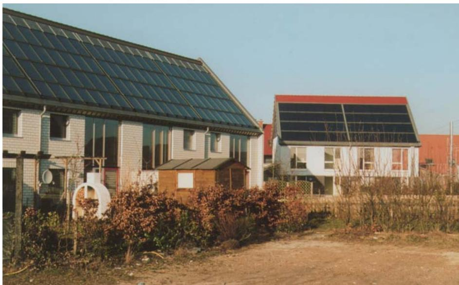
**Bild 2.41: Reihenhausezeile und Doppelhaus mit Kollektorflächen**
