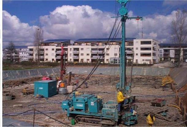
**Bild 4.21: 2. Ausbau des Erdsonden-Wärmespeichers**
