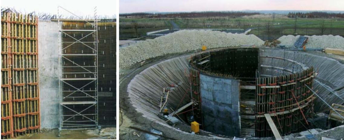
**Bild 4.8: Bau der zylindrischen Speicherwand**
