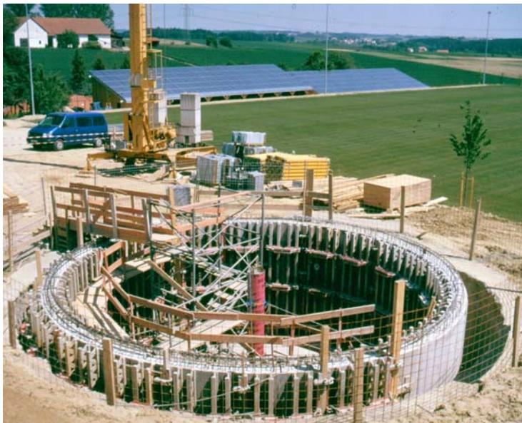
**Bild 4.32:** Bau des Betonbehälters
