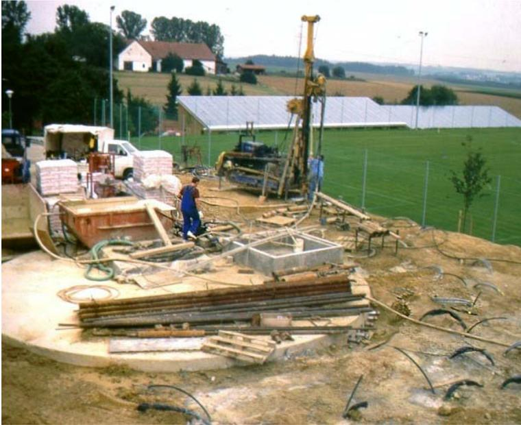
**Bild 4.33: Ringförmig um den Betonbehälter angeordnetes Sondenfeld**
