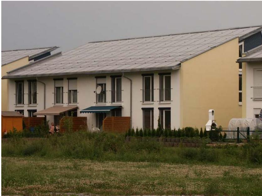
Das Kollektorfeld auf den Reihenhäusern der Baden-Württembergischen-Bank, im Folgenden Reihenhäuser BW, siehe Bild 2.23, wurde als Kollektordach ausgeführt. Bei einem Gebäude wurde das Kollektordach ohne Unterdach installiert, die Kollektoren bilden die einzige dachdichtende Ebene.
