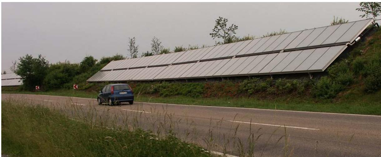
**Bild 2.24: Kollektorfeld auf dem Lärmschutzwall**
