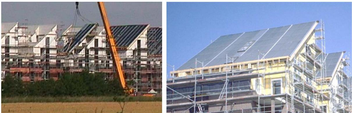
**Bild 2.57: Montage der Kollektordächer**
