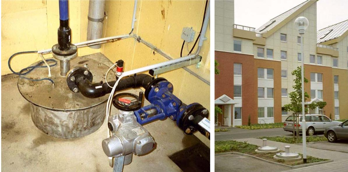
**Bild 2.60: Brunnenkopf mit Förder- und Injektionsleitung (linkes Bild); Einstiegsschächte zum Brunnenkeller der kalten Bohrung (rechtes Bild)**
