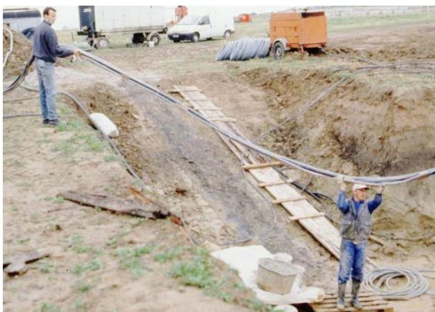
**Bild 4.22: Einbringung der Sonden beim Pilotspeicher**
