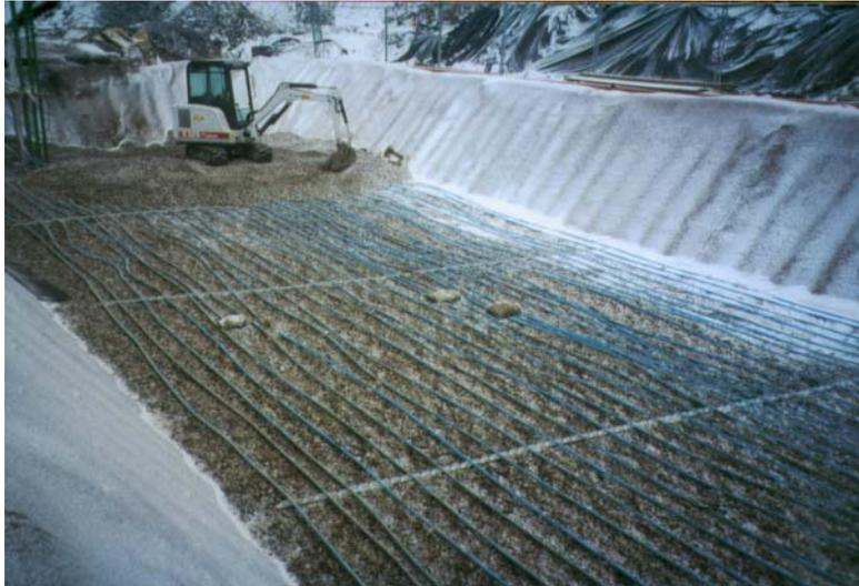
**Bild 4.18: Lagenweiser Einbau der Wärmeübertragerrohre**
