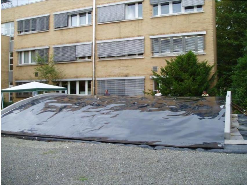
**Bild 173: Freitragende Abdeckung mit Regenschutzbahn**
