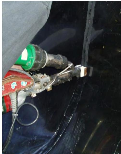
**Bild 105: Heißluft- (links) und Extrusionsschweißen (rechts)**
