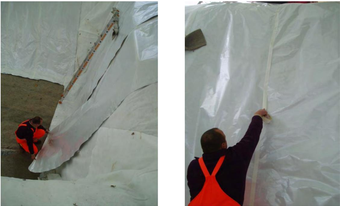
**Bild 98: Konventionelle Verlegung einer (gewebeverstärkten) Dampfsperre: Überlappung und Fixierung mittels Klebeband**
