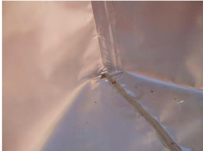
**Bild 103: Trotz der geringen Foliendicke von unter 1 mm gelingen Doppelnähte. Auch Extrusionsnähte im Eckbereich lassen sich ausführen.**
