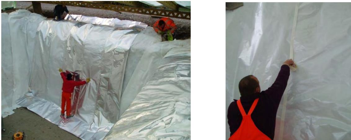
**Bild 142: Einbringen der vorkonfektionierten Dampfsperrplane (links) und Verkleben der konventionellen Dampfsperre (rechts)**
