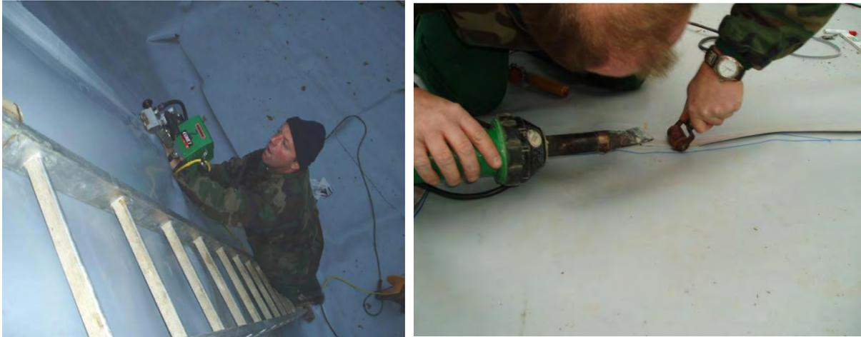
**Bild 99: Verschweißen einer TPE-Abdichtung mit dem Heizkeil-Schweißautomaten (links). An den Ecken und an T-Stößen werden die Bahnen per Hand mit Heißluft verschweißt.**
