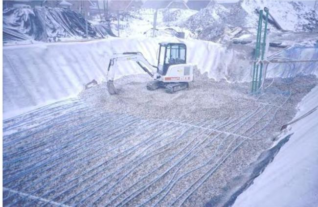
**Bild 129: Rohrschlängensystem im Kies-Wasser Speicher Steinfurt-Borghorst (1999), [3]**
