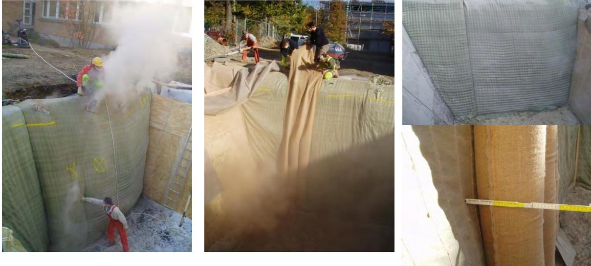
**Bild 88: Verfüllen von schütffähiger Wärmedämmung in Geocontainer und in Schläuche**
