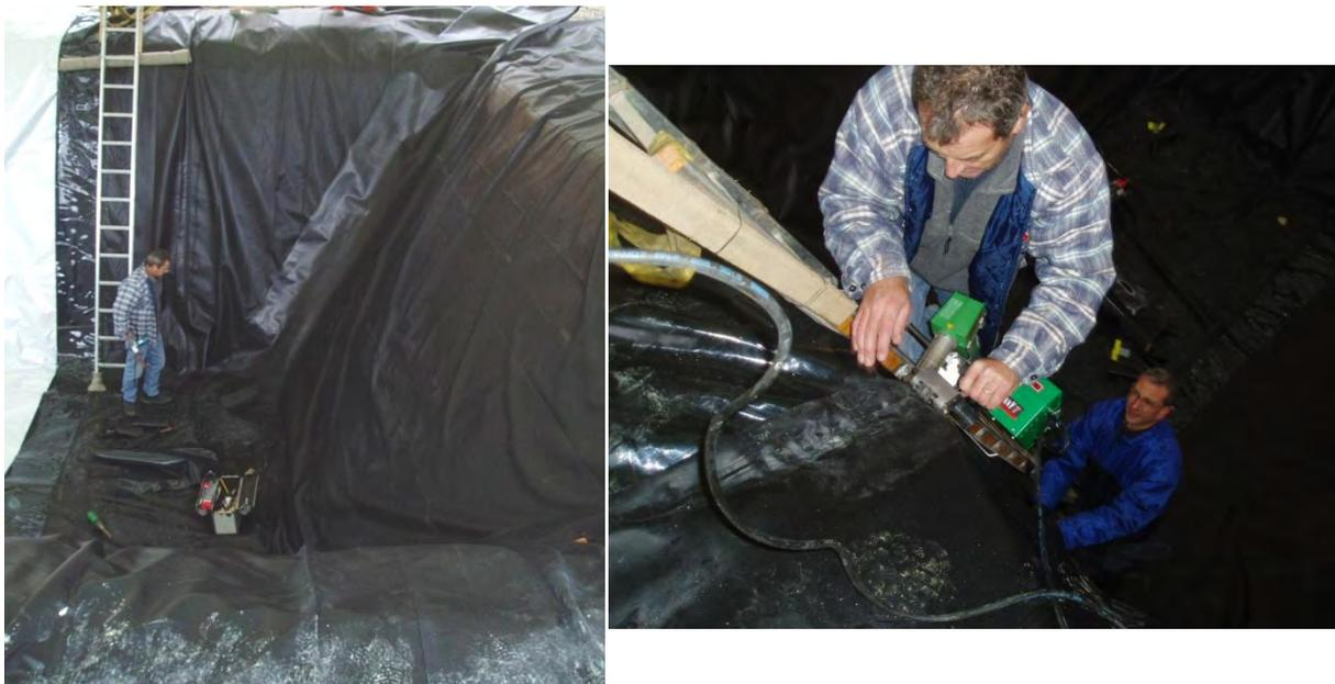
**Bild 100: Abdichtung des Beckens mit einer vorgefertigten Plane aus EPDM; Das Verschweißen der Planen mittels Schweißautomaten ist aufgrund der hohen Flexibilität des Materials schwierig: Der Schweißautomat „kommt leicht aus der Spur“. Für das Verschweißen von EPDM wird eine spezielle Beschichtung, ein sogenannter Fügerand benötigt.**
