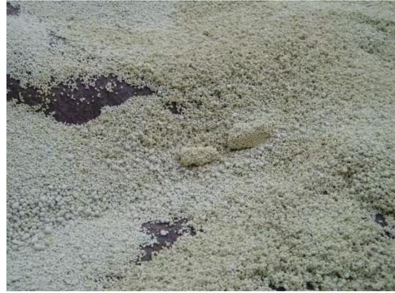
**Bild 143: Durchfeuchtete Dämmung (und Schutzvlies) der Abdeckung von Labor 1 (links), Detailansicht sowie Verklumpung der nassen Dämmung (rechts)**
