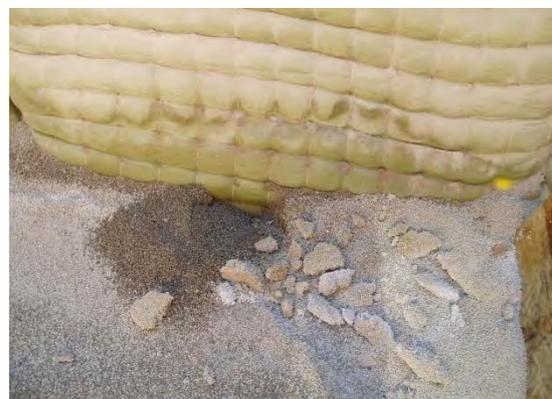
**Bild 114: Durchfeuchtung der Nordwand (W2) sowie des Bodens (B) nach dem Rückbau**
