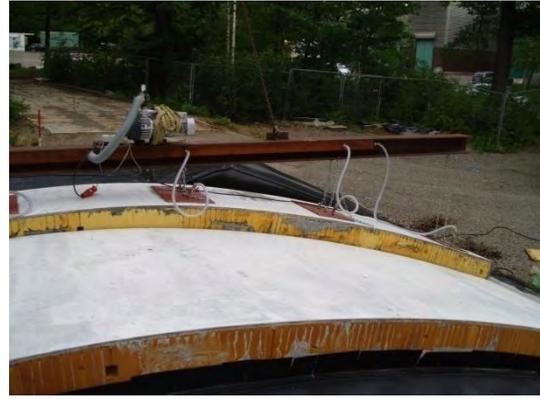
**Bild 168: Versetzen der 1 m breiten Elemente zwischen die 2 m breiten Elemente**
