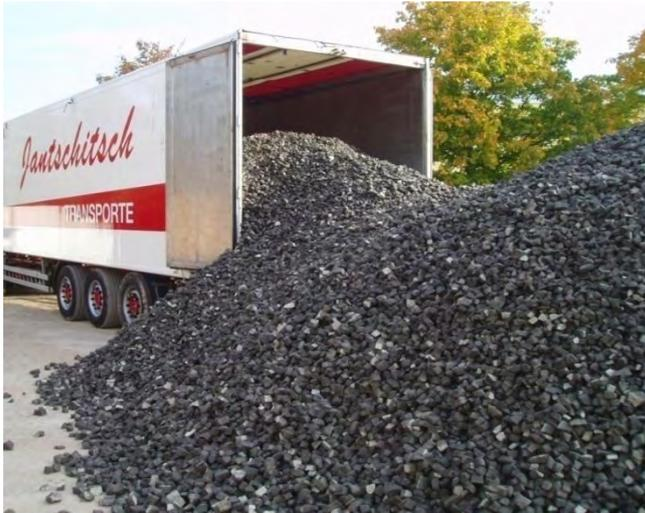
**Bild 55: Lieferung der SGS Schüttung im abgedeckten LKW,  $25 \text{ kg/m}^3$  wies die Wärmedämmung auf. Feuchtigkeitseintrag durch Beladen des LKW bei Starkregen.**
