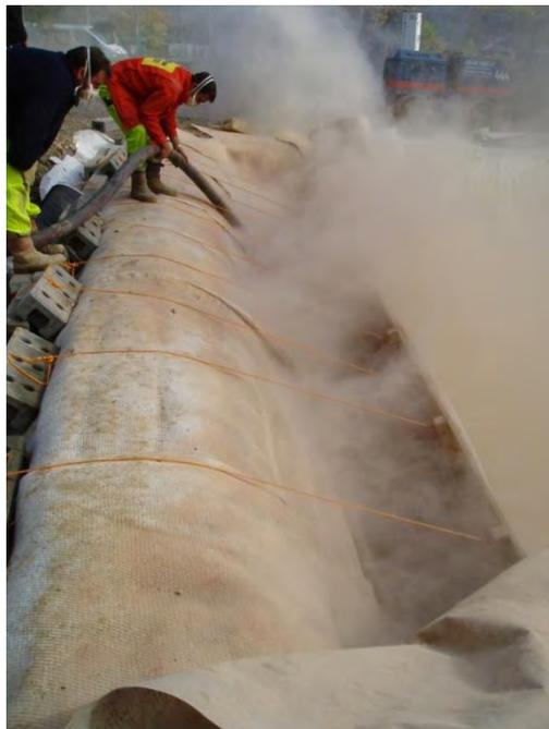
**Bild 85: Staubentwicklung beim Einblasen**
