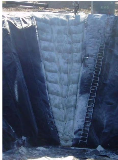
**Bild 89: Verfüllen von schütffähiger Wärmedämmung in Geocontainer auf 35° Böschung des Kies-Wasser-Wärmespeichers in Eggenstein-Leopoldshafen**
