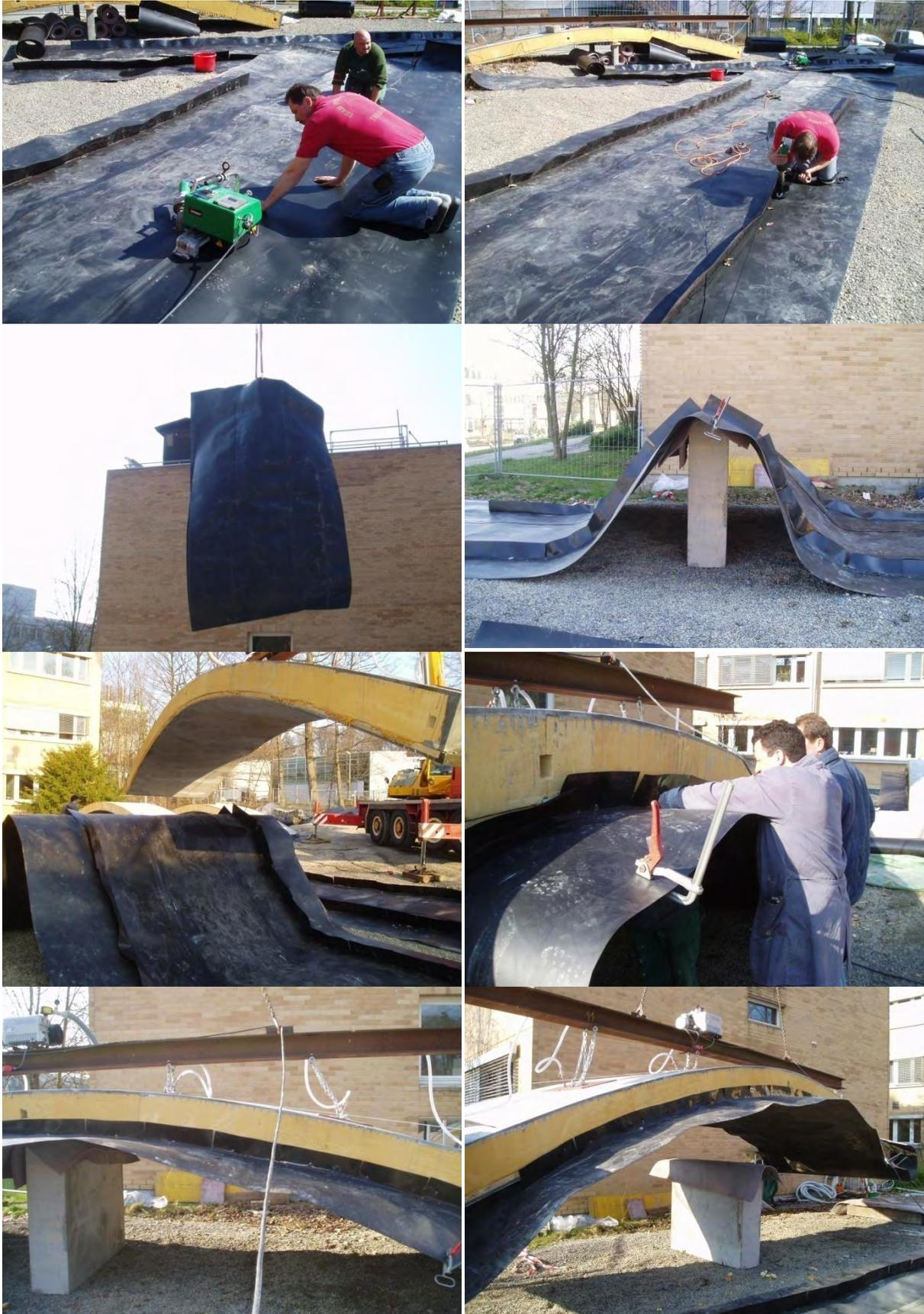
**Bild 163: Vorbereitung der Abdichtbahn, die vor dem Versetzen von unten an den Elementen befestigt wird. Die Befestigung der Abdichtbahn erfolgt seitlich über Stahlanker, die durch angeschweißte L-Stücke in die PUR-Schicht knapp über dem Beton geschlagen wurden.**
