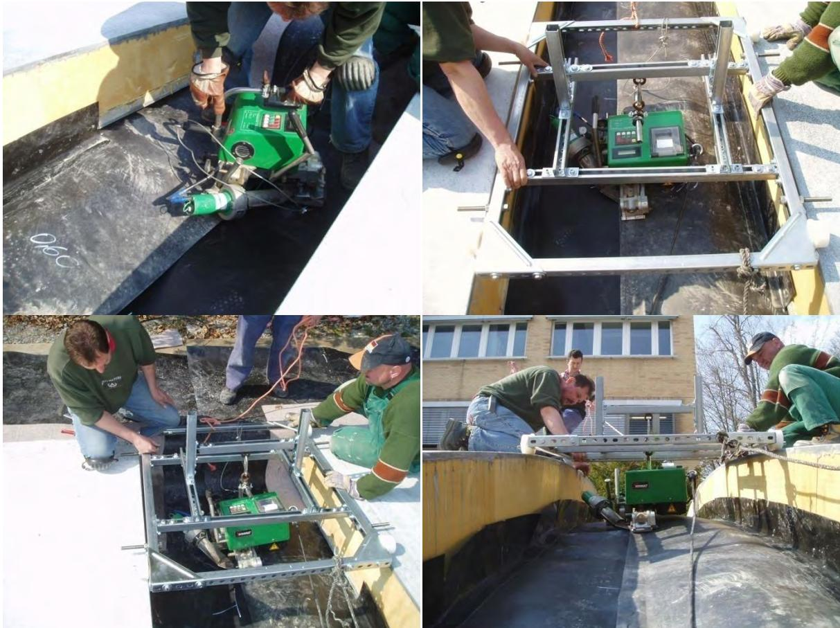
**Bild 165: Das Verschweißen der Abdichtung erfolgt ohne Gerüst zwischen den Elementen von oben. Dafür wurde ein Wagen entwickelt, in dem der Schweißautomat eingehängt wird. Der Schweißautomat zieht sich und den Wagen von einer Speicherseite zur anderen. Der Schweißer muss nur leichte Richtungskorrekturen vornehmen.**
