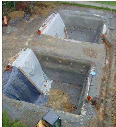
**Bild 82: Herstellung der Gruben als Basis für die Außenlaborversuche, oben:(kleines) Bohrgerät; Mitte links: Bewehrung und rechts anbringen des Spritzbetons; unten: fertiggestellte Gruben**
