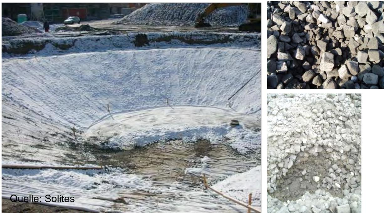
**Bild 54: Schneebedeckte Schaumglasschotter-Wärmedämmung beim Projekt SNAB München-Ackermannbogen (links), feucht angelieferte Wärmedämmung in Eggenstein-Leopoldshafen (rechts oben), nasse SGS Wärmedämmung beim Außenlaborversuch (rechts unten)**
