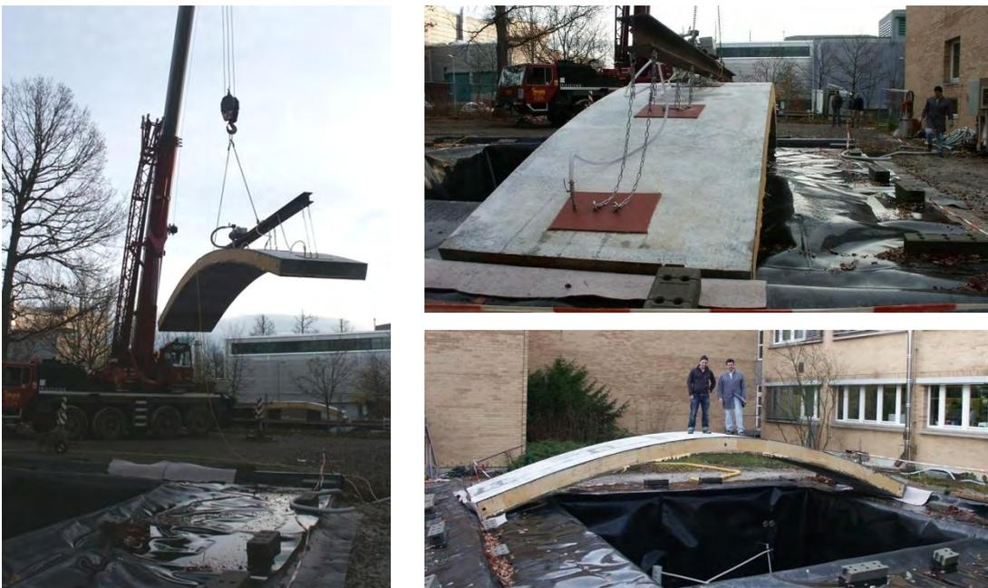
**Bild 162: Autokran beim Heben eines Sandwichelements mittels Vakuumhebezeug, Montage des ersten Fertigteils auf dem Außenlabor-Heißwasser-Erdbecken-Wärmespeicher am ITW**
