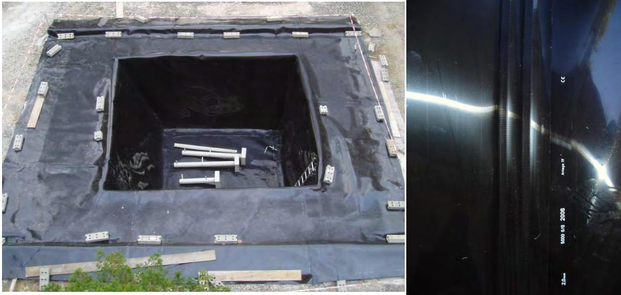
**Bild 101: Abdichtung eines Beckens mit HDPE. Aufgrund der Erfahrungen beim Deponiebau erfolgt die Abdichtung problemlos; rechts: Doppelnaht**
