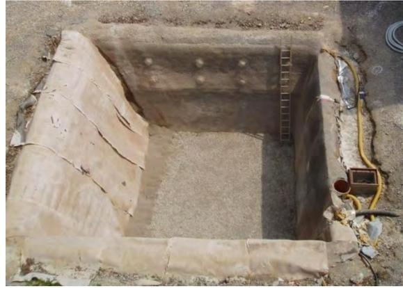
**Bild 8: Links: Stabilisierung der Böschung durch Vernagelung mit anschließender Spritzbetonschicht (Züblin Spezialtiefbau), rechts: Außenlabor mit vernagelter Böschung (ITW)**
