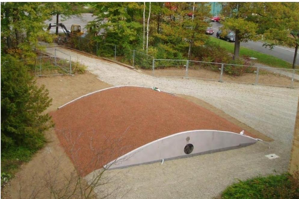
**Bild 174: Freitragende Abdeckung mit extensiver Dachbegrünung**
