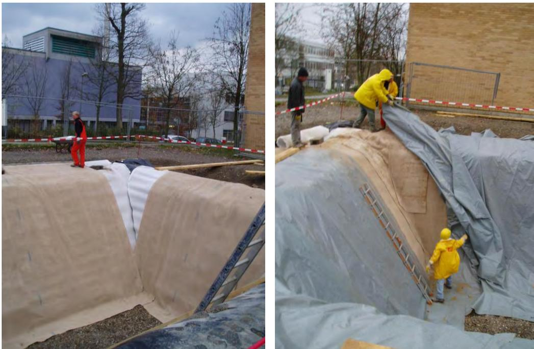
**Bild 127: Verlegung in breiten Bahnen, Kanten werden mehrfach überlappend ausgeführt**
