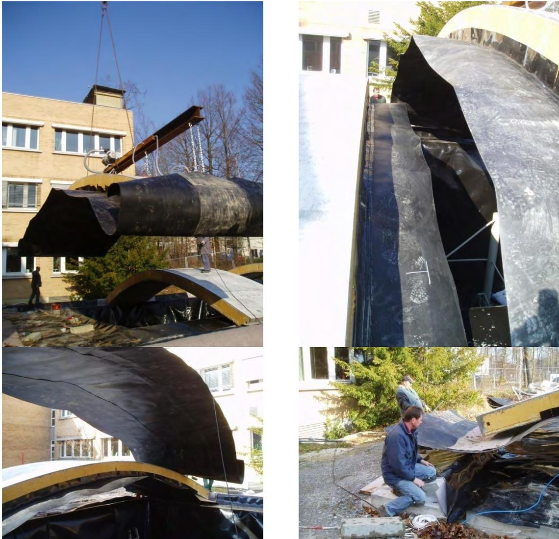
**Bild 164: Die 2 m breiten Elemente werden mit einem Abstand von 1 m auf das Auflager gesetzt. Die Sperrschichtbahn wird nach außen gezogen, um später das Verschweißen mit der Abdichtung des Beckens von außen zu ermöglichen.**
