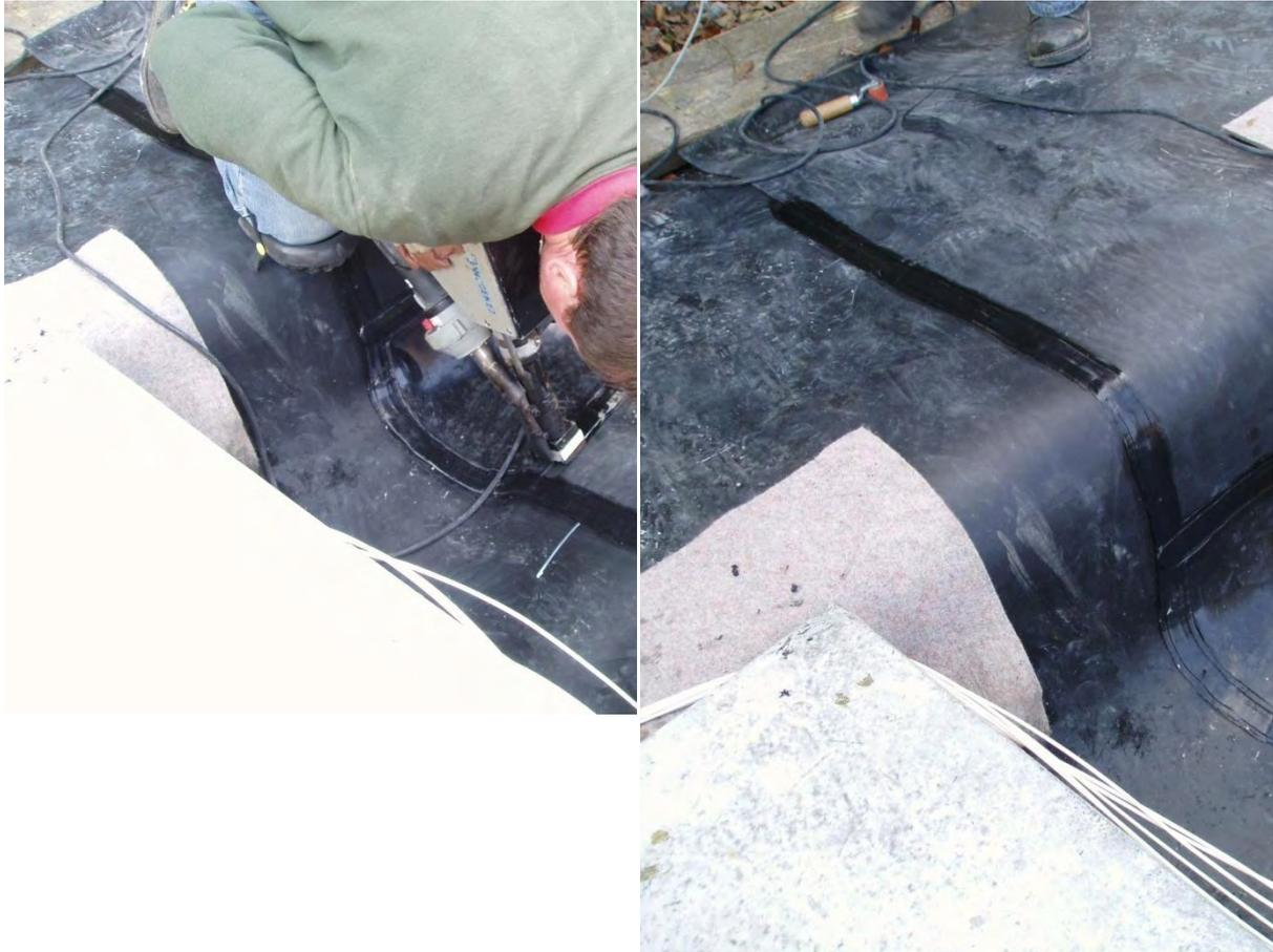
**Bild 166: Im Randbereich am Auflager werden die Bahnen mit Extrusionsnähten verschweißt.**
