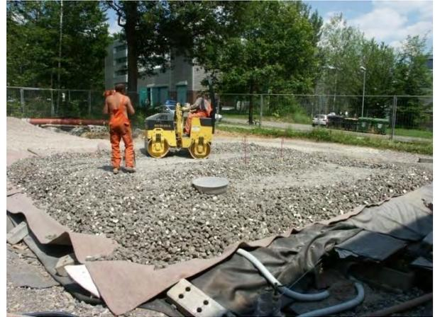
**Bild 95: Einbringen und Verdichten der Dämmung der Abdeckung von Labor 2, Abdeckung des Versuchs Wasserwegsamkeit**
