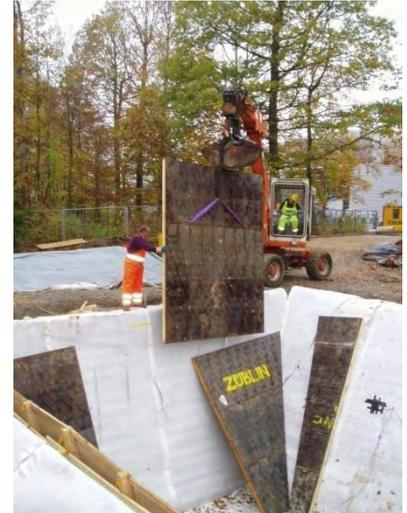
**Bild 90:** Durch das Verfüllen von schüttfähiger Wärmedämmung zwischen Schalung und Erdreich gelingt eine effektive Installation der Wärmedämmung.
