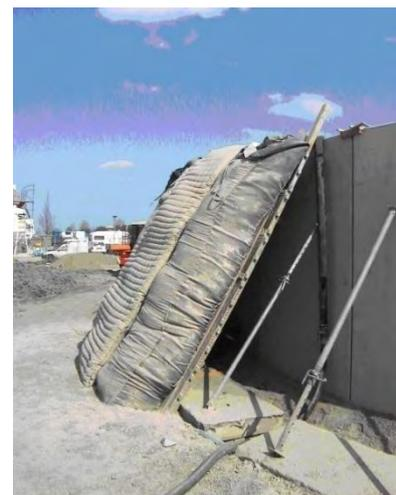
**Bild 87: Vorversuche beim Bau des Wärmespeichers in Hannover, schüttfähige Wärmedämmung in Geocontainern (PKi)**
