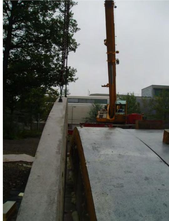
**Bild 171: Versetzen der 1 m breiten Elemente und der Endschotts, die Fugen werden mit PUR Ortschaum ausgeschäumt**
