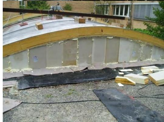
**Bild 169: Das Verschweißen der Abdichtung und das Anbringen der PUR/PIR-Wärmedämmung im Bereich der Endschotts erfolgt neben dem Becken.**
