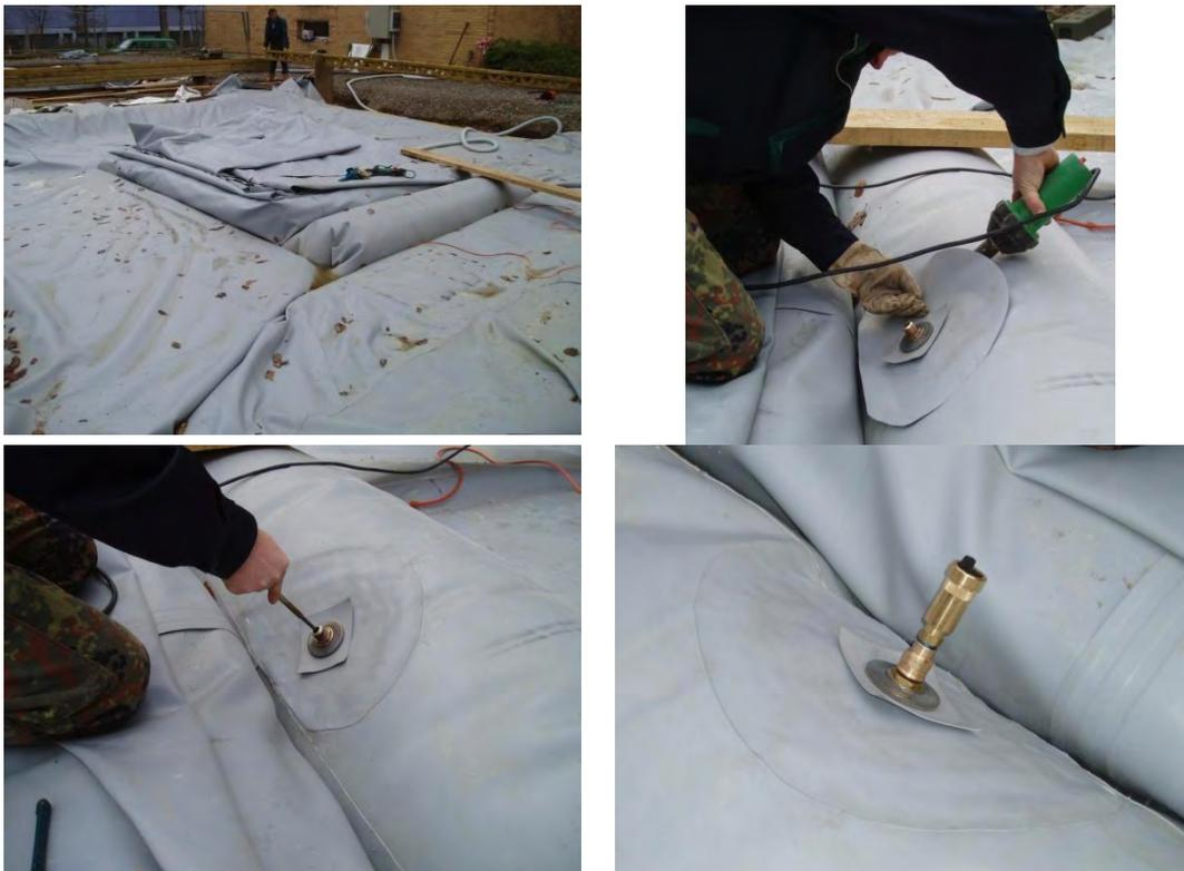
**Bild 145: Entlüftung bei aufschwimmender Abdeckung**
