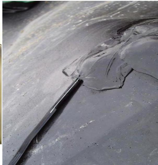
**Bild 104: Die Sperrschichtbahn ist im Vergleich zur HDPE-Bahn weniger flexibel. Aufgrund der Bahnbreite von nur 1.5 m sind im Vergleich zu HDPE etwa viermal so viele Schweißnähte auszuführen.**
