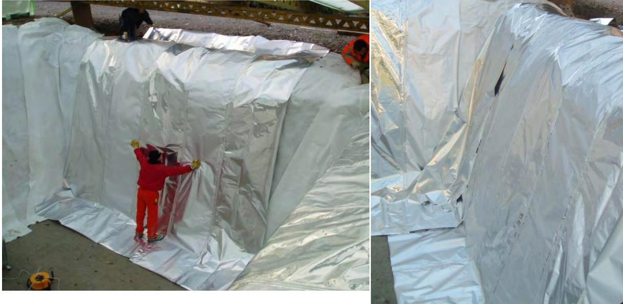
**Bild 97: Verlegen einer vorkonfektionierten Plane, verschweißt aus 1.5 m breiten Dampfsperrbahnen, an den Kanten erfolgt eine überlappende Verlegung**
