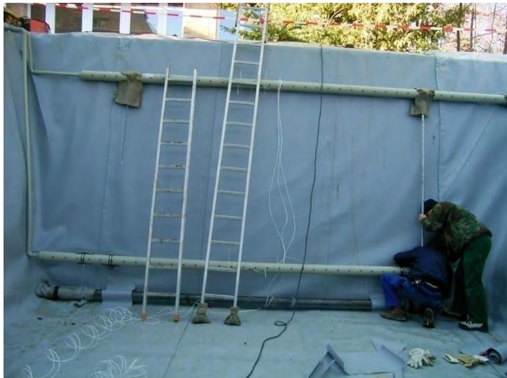
**Bild 141: Montage des Beladesystems (vor der Installation der Abdeckung)**
