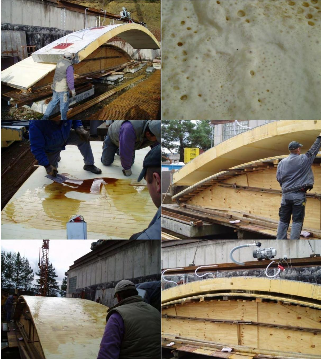
**Bild 161: Das Verkleben der Elementhälften mit PUR-Kleber muss innerhalb von 20 bis 30 min abhängig von Umgebungstemperatur und Feuchte geschehen.**
