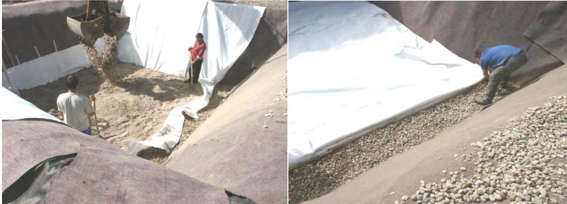
**Bild 132: Bau des Forschungsspeichers, links Einbringen der Sandschicht und rechts Einpacken der fertigen Schicht in Vliesstoffe, um das Ausschwemmen des Sandes zu verhindern; vertikale Kiesschicht am rechten Rand des Speichers**
