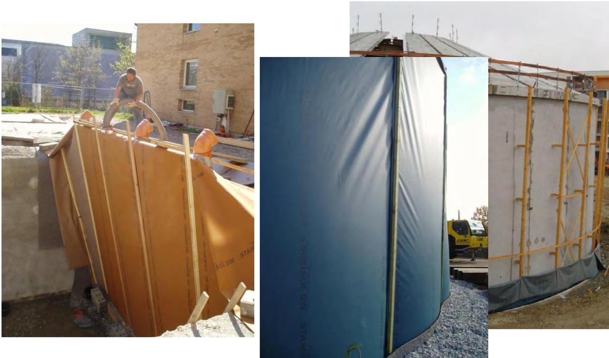
**Bild 92: Membranschalung, Vorversuch im Außenlabor und Anwendung im Pilotprojekt in München-Ackermannbogen**
