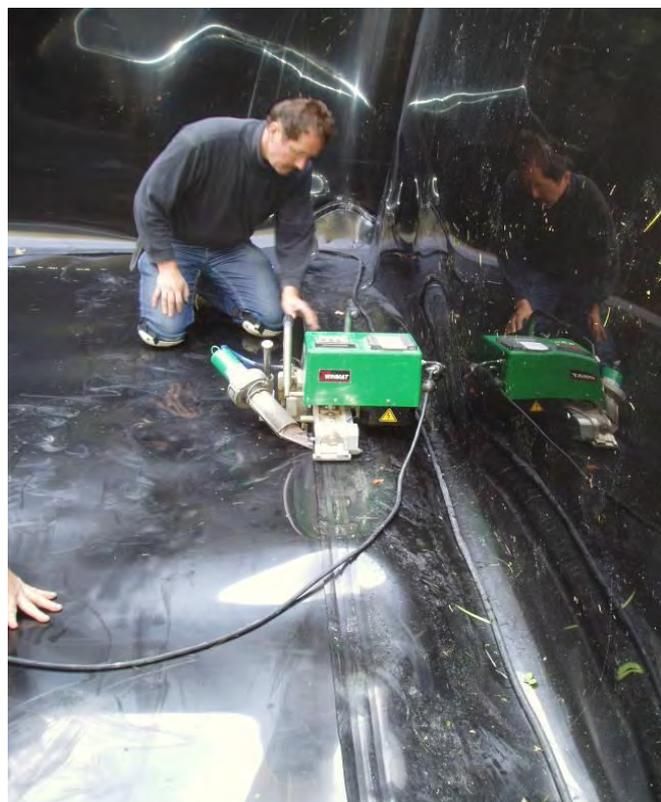
**Bild 106: Doppelnähte mit dem Schweißautomaten (hier kombiniert Heißluft und Keil)**
