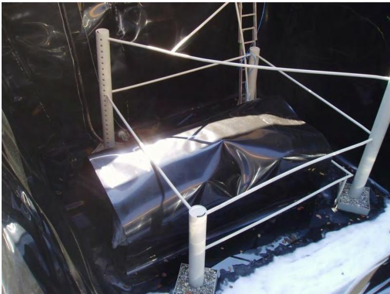
**Bild 125: Schichtbeladeeinheit aus PP der Fa. Ratiotherm mit Membranausdehnungsbehälter, vgl. Kapitel 7.11**
