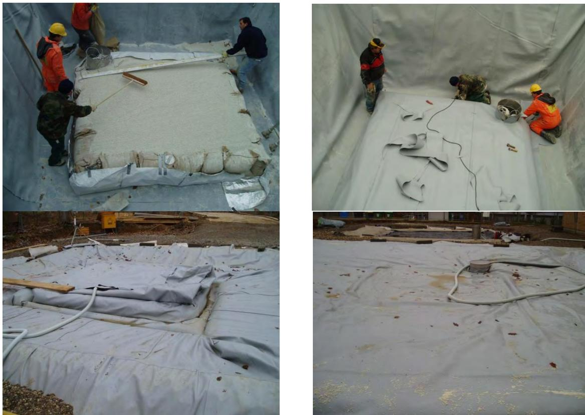
**Bild 140: Aufschwimmende Abdeckung, links oben: Herstellung der Dämmschichtmatratze; rechts oben: hermetisches Einschweißen der Dämmschichtmatratze; unten links: aufgeschwommene Abdeckung, Randdämmung fehlt noch; unten rechts: fertig gestellte aufschwimmende Abdeckung**
