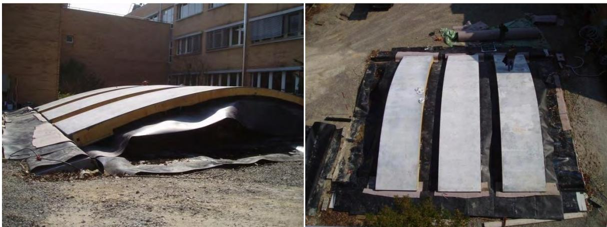
**Bild 167: Erdbecken-Wärmespeicher mit drei Elementen und verschweißter Sperrschichtbahn**
