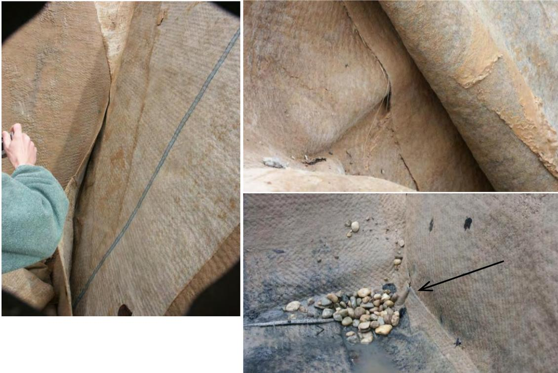
**Bild 128: Mögliche Undichtigkeitsstellen – links oben: Verlegung von Gewebe auf Gewebe; rechts oben: Faltenbildung durch Absackung; rechts unten: Falte im Eckbereich des Bodens**
