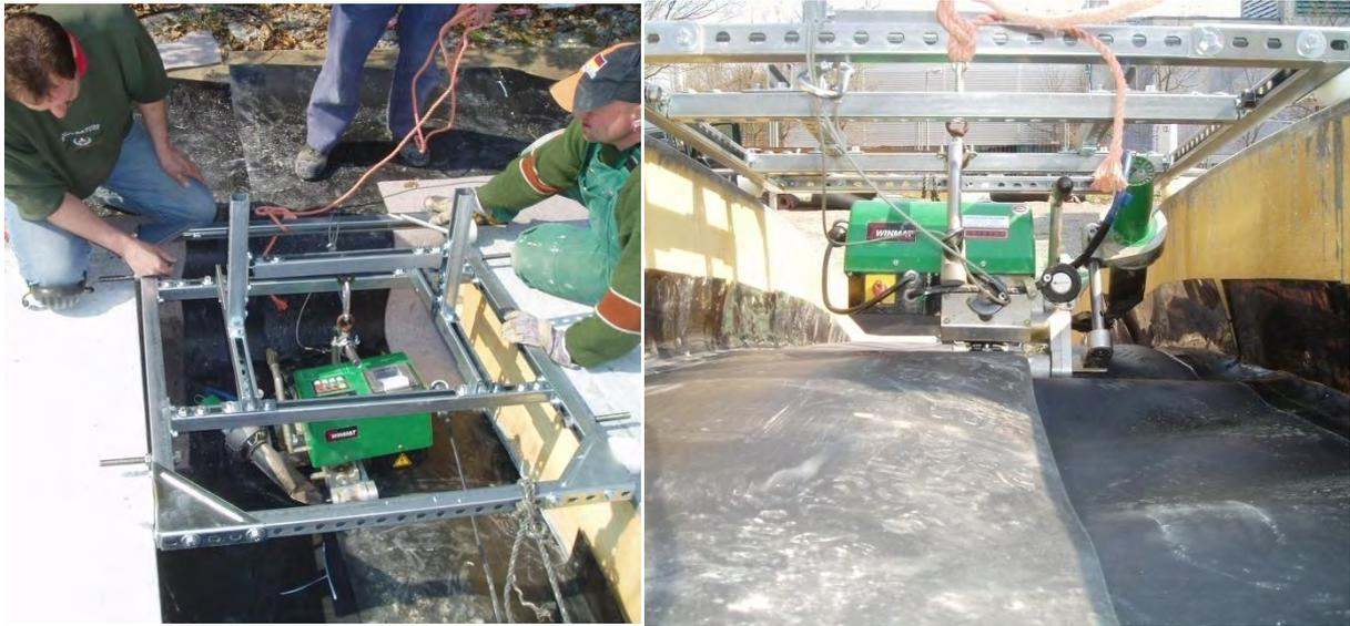
**Bild 107: Verschweißen der Sperrschichtbahn zwischen den Abdeckungselementen mittels Schweißautomat und Führungswagen (vgl. Kapitel 7.10.7)**
