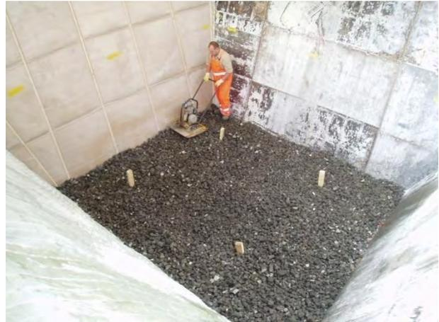
**Bild 94: Einbringen und Verdichten der Bodendämmung**
