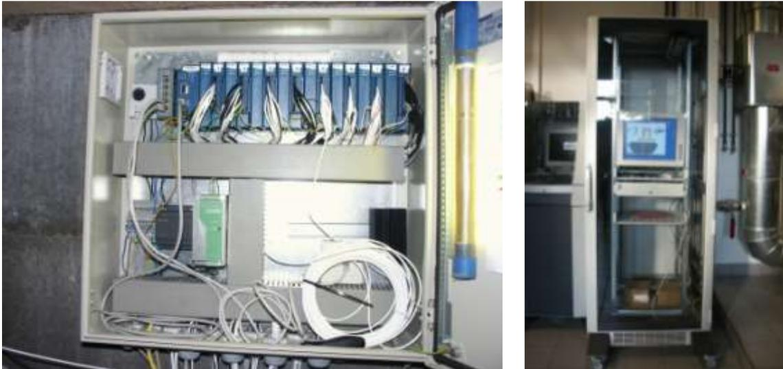
**Bild 3.2-16: Schaltschrank im „Vakuumschacht“ beim Wärmespeicher (links), Schaltschrank mit Industrie PC in der Heizzentrale (rechts)**
