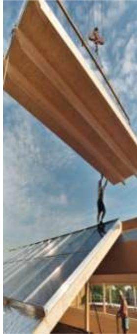
**Bild 3.2-4: Einbau der Kollektorelemente in das Sheddach der neuen Sporthalle (Quelle PKi)**
