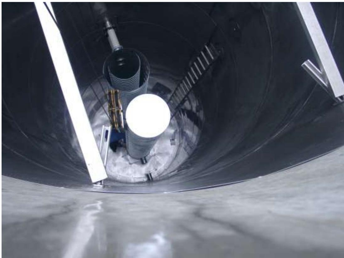
**Bild 3.1-7: Schichtbeladeeinrichtung des 100 m<sup>3</sup> Pufferspeichers**
