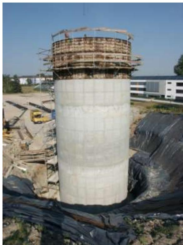
Bild 3.1-8: Bauweise der Pufferspeicher mit Fertigteilen (links) bzw. in Ortbeton (rechts)
