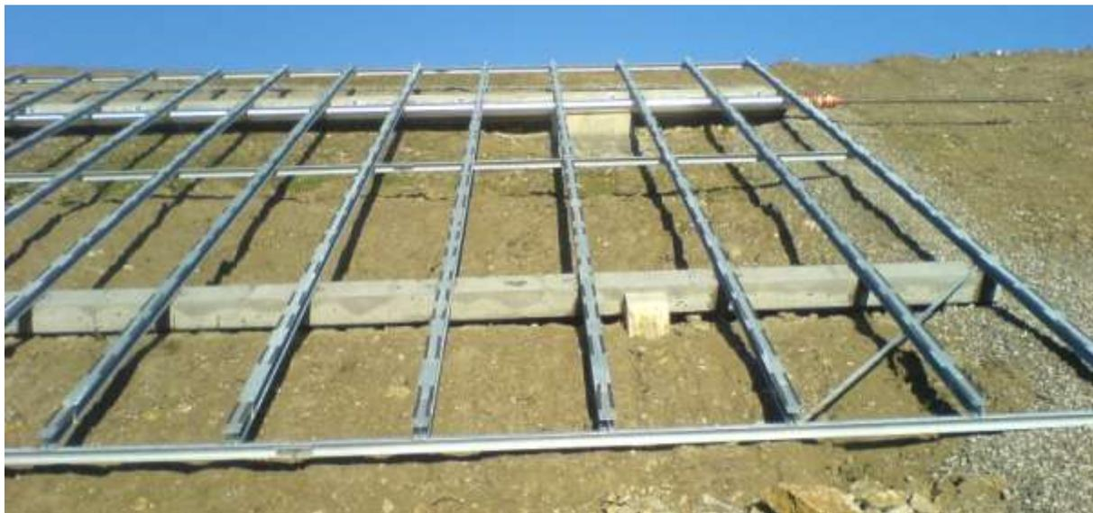
**Bild 3.1-6: Unterkonstruktion der Wallkollektoren in gemischter Beton-/Stahlbauweise**
