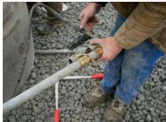
**Bild 3.1-13 Doppel-U-Rohrsonde aus PE-X (links) und direkte Lage im Schaumglasschotter mit Schiebehülensverbindung (rechts)**
