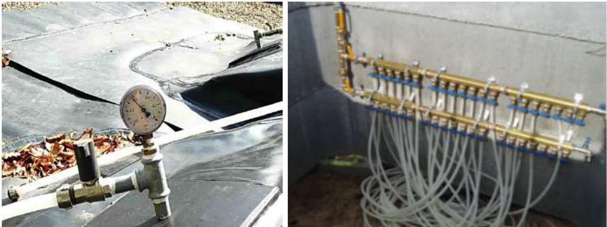
**Bild 3.2-9: Evakuieren einer Kammer (links; Quelle PKi), Leckageprüfsystem im „Vakuumschacht“ am Wärmespeicher (rechts)**
