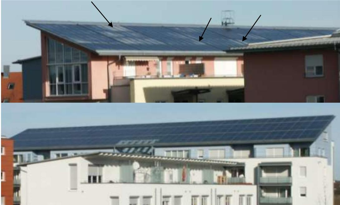
**Bild 2.1-4: Beschlagene Kollektorfelder im BA1 (oben) und unbeeinträchtigte Kollektorfelder im BA2 (unten); 8. Januar 2008, 12:00 Uhr**
