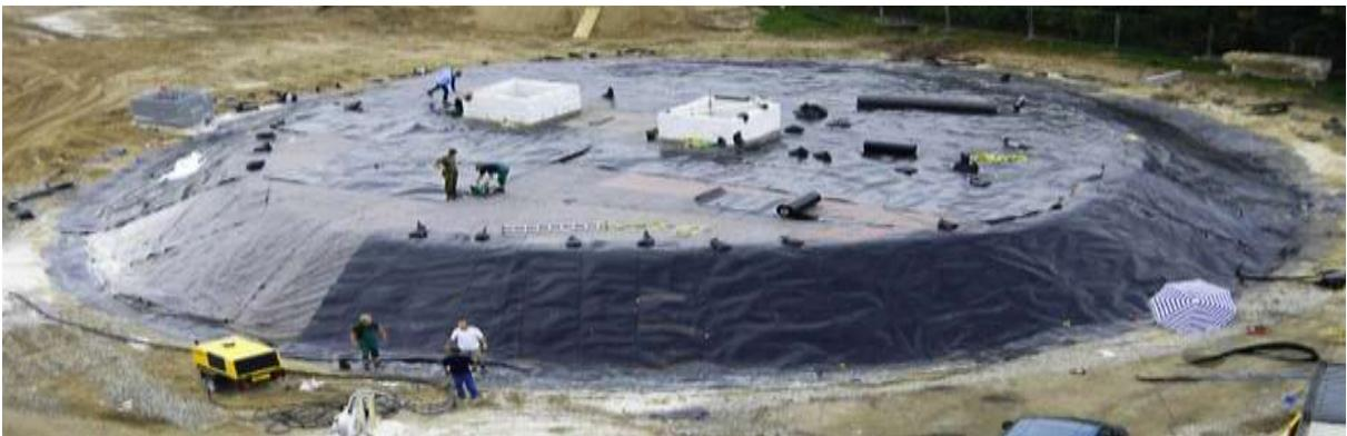
**Bild 3.2-6: Unterschiedliche Baustadien des KWWS; Verlegung von Schutzvlies auf die Böschung, Füllen des Kies-Sand-Kies Speichermediums, obere äußere Abdichtung**
