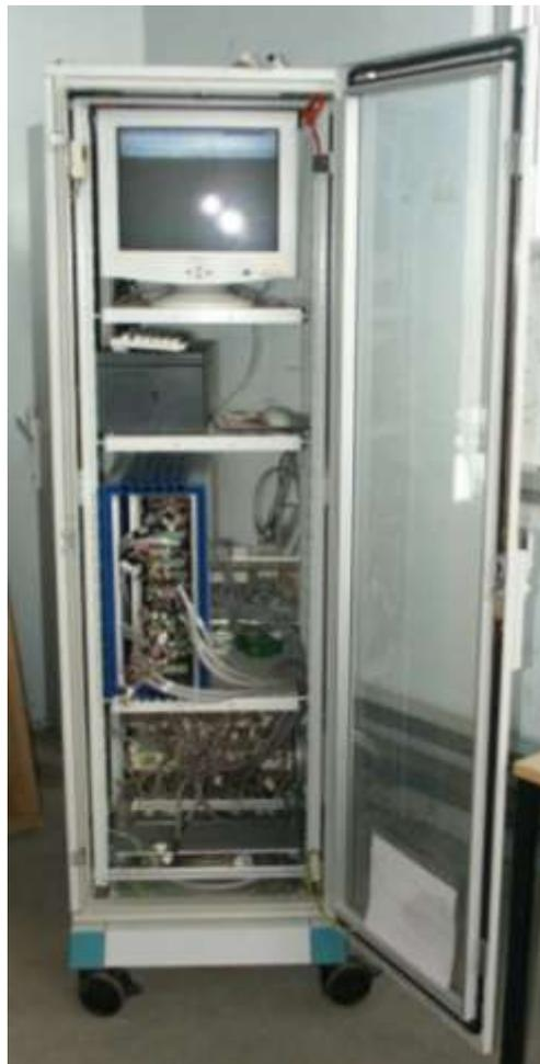
**Bild 2.1-13: Erneueres Messdaten-Erfassungssystem in der Heizzentrale**
