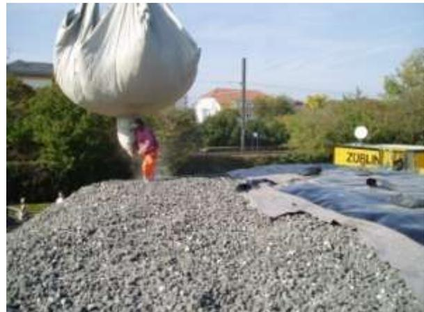
**Bild 3.2-10: Einbringen der Dämmmaterialien in die Kammern während des Speicherbaus**
